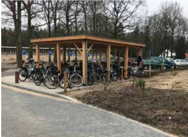
fietsenstalling bij hoofdentree, bij parkeerplaats medewerkers komt een grotere stalling
