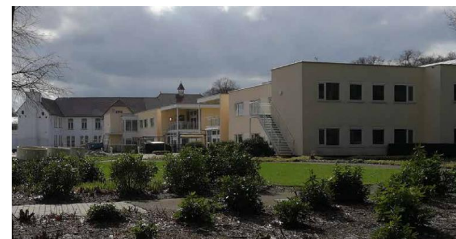
Figuur 2: Te behouden gebouw De Emmapleinen (rechts) voor de duurzame herontwikkeling.
