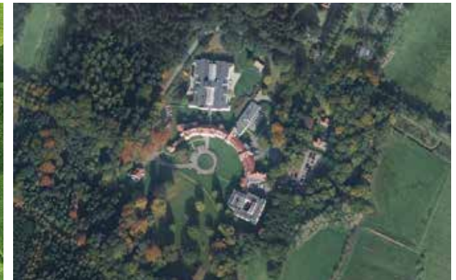
Luchtfoto van na 1996, het jaar waarin het zorggebouw De Emmappleinen is gerealiseerd. Het nieuwe zorggebouw is - evenals eerdere toevoegingen - radiaal op het historische hoofdgebouw geplaatst.
