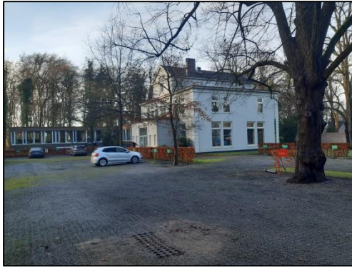
Plangebied gezien vanuit de noordoostkant, met op de achtergrond de villa en uitbouw.
