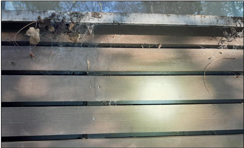
Houten aftimmering bij de uitbouw. De latten zitten op enige afstand van elkaar, waardoor vleermuizen achter de aftimmering weg kunnen kruipen.
