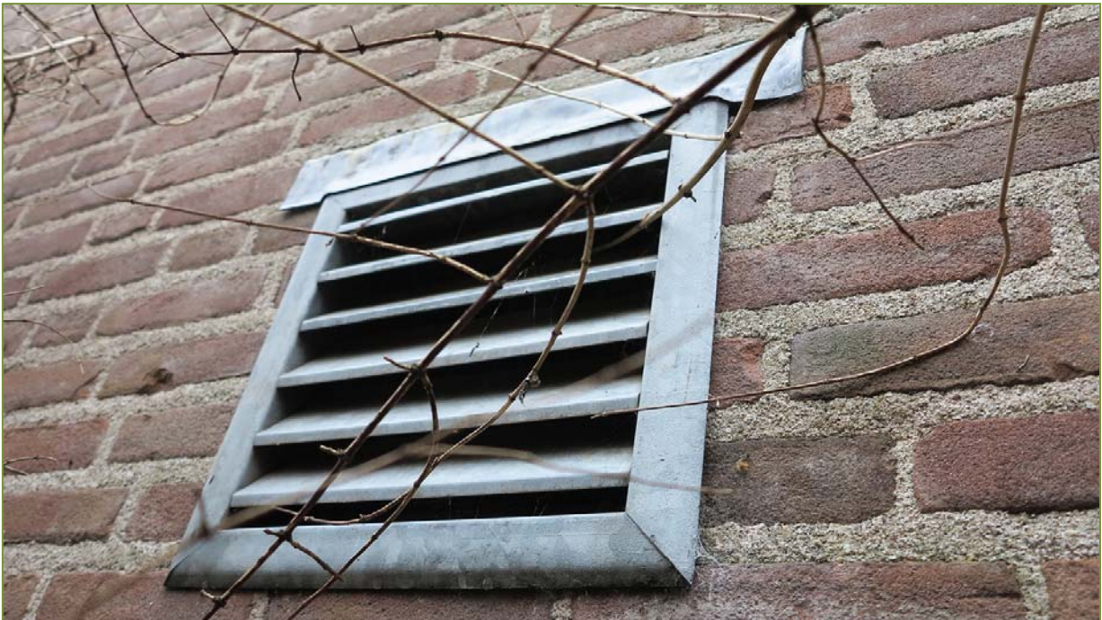
Een van de grotere luchtroosters in de muren van het rouwcentrum, als mogelijke entree voor vleermuizen, ofschoon minder geschikt dan de open stootvoegen, die hoger gesitueerd en toegankelijker zijn.
