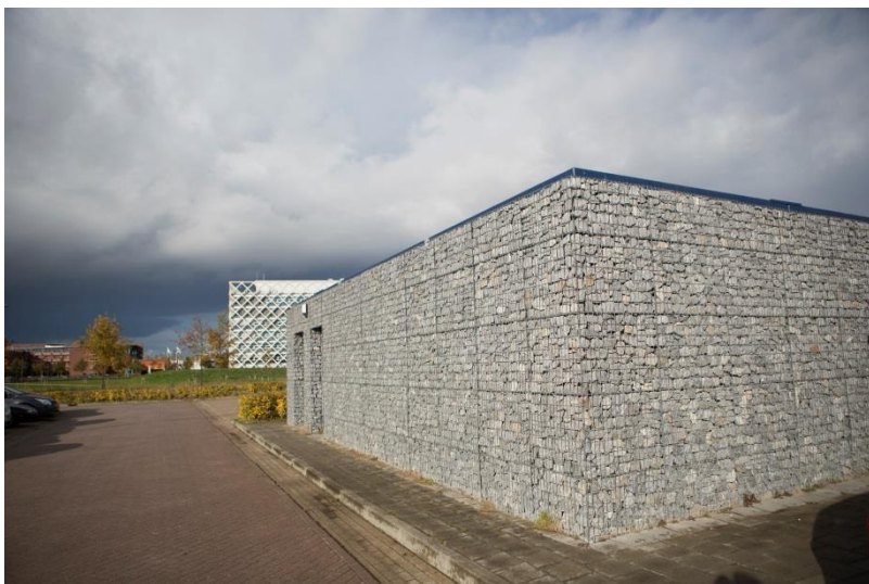
Figuur 4 Stenen gebouw op parkeerplaats, mogelijke nestlocatie witte kwikstaart of zwarte roodstaart
