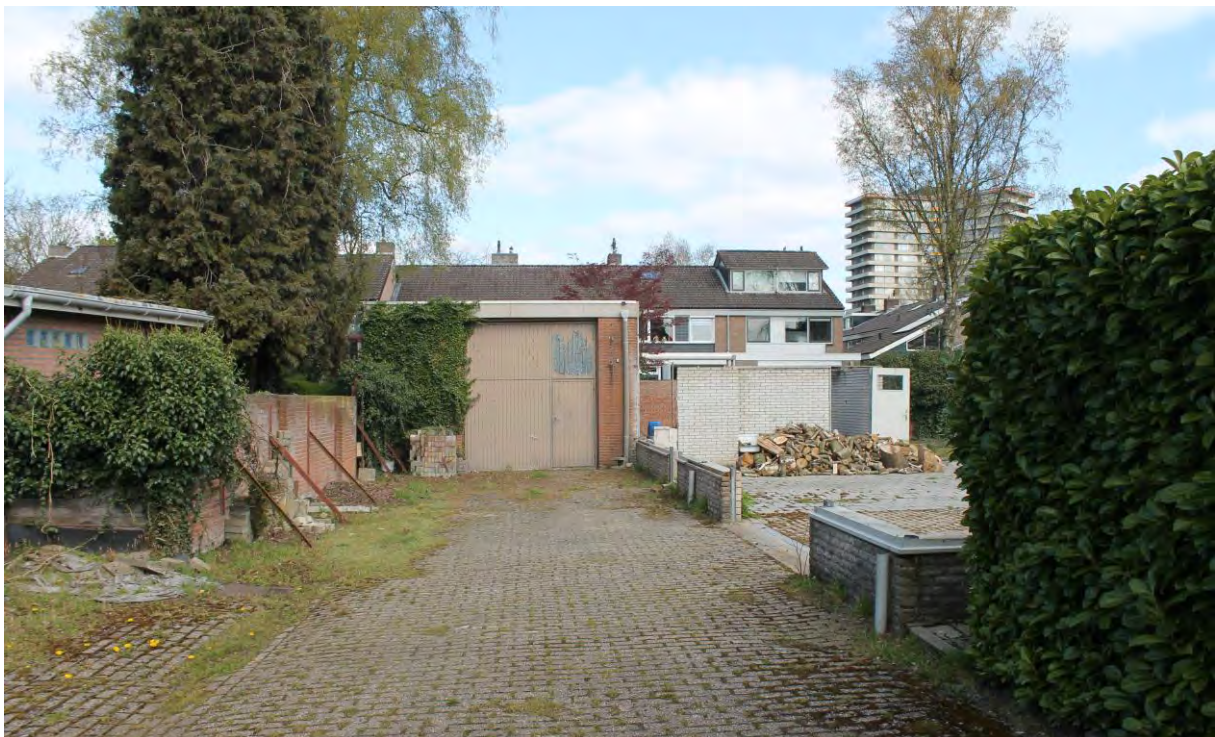
HET TERREIN MET VERHARDINGEN EN BOUWRESTANTEN; ZICHT VANAF DE OOSTSTEEG
