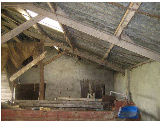
Foto 3: Dakconstructie kapschuur (A)
