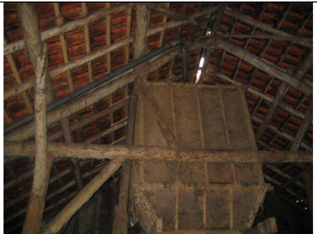
Foto 18: Dakconstructie en opening (E)
