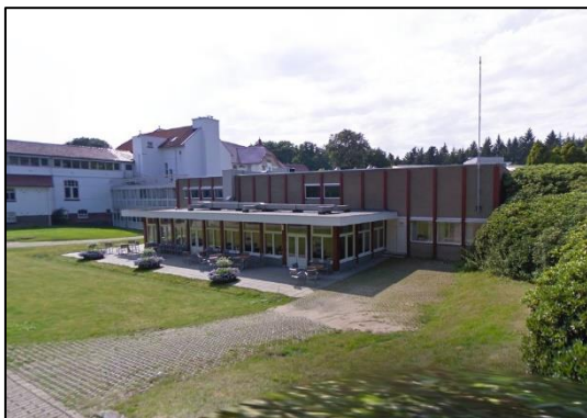
Te slopen bebouwing ten noorden van Sanatorium (Bron: www.google.nl/maps )
