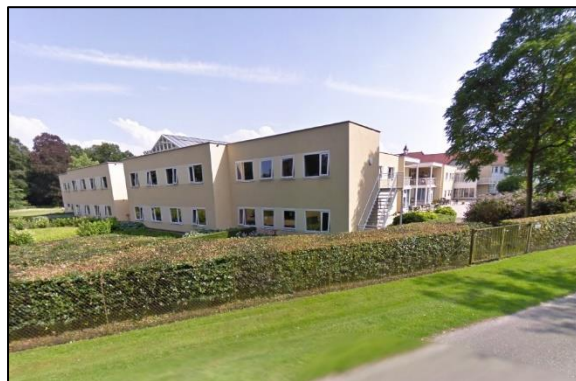
Te slopen bebouwing ten noorden van Sanatorium (Bron: www.google.nl/maps )
