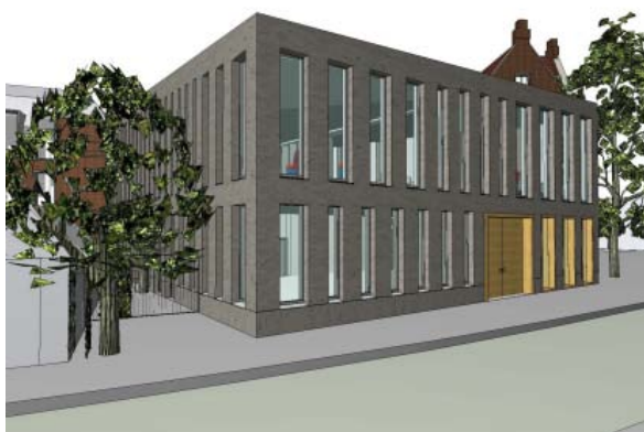
Figuur 4: Nieuwbouw deel
