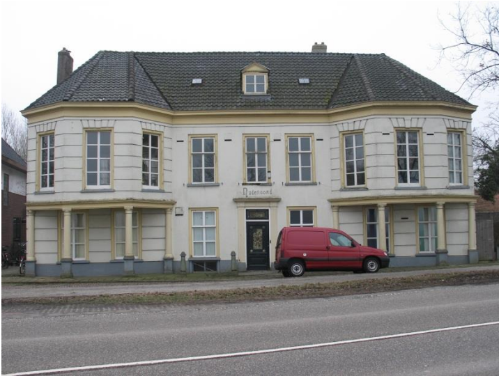
Het pand 'Nudenoord' in zijn recente verschijningsvorm
