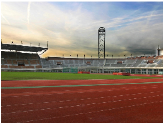
Olympisch Stadion Amsterdam na restauratie.
