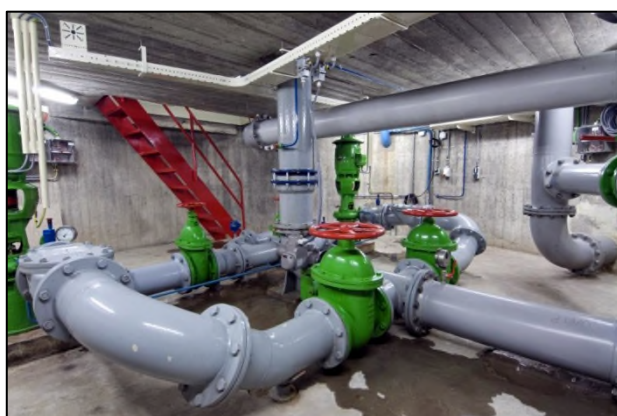
Fig. 5,6,7 Interieur Watertoren Bron: RCE Amersfoort
