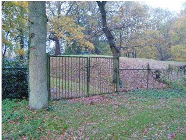
Figuur 15. Westzijde terrein met grondlichaam boven reinwaterkelder.
