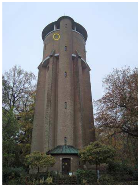
Figuur 18. Noordzijde watertoren met locatie hangplaats van Grootoorvleermuis.
