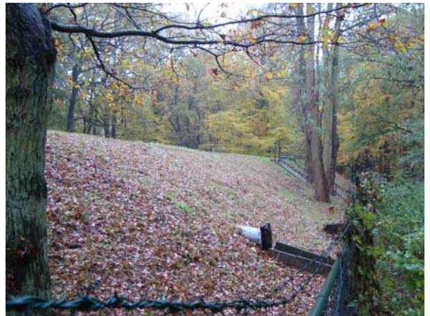
Figuur 16. Westzijde terrein met talud grondlichaam.
