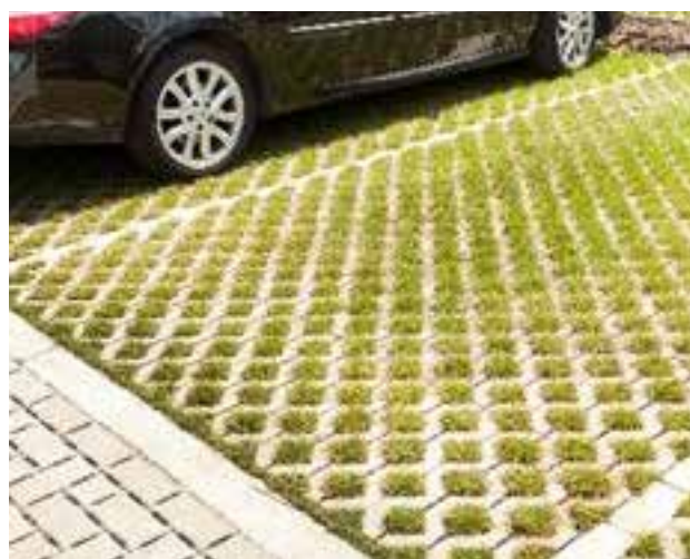
Parkeervakken parkeerkoffer: grasbetonstenen
