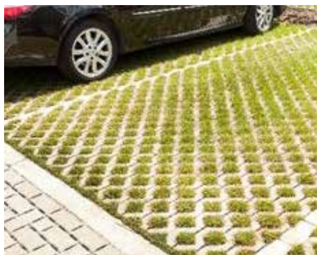
Parkeervakken parkeerkoffer: grasbetonstenen
