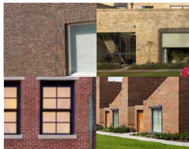
Industrieel karakter door o.a. donker en esthetisch metselwerk, grote raamopeningen, betonnen lateien
