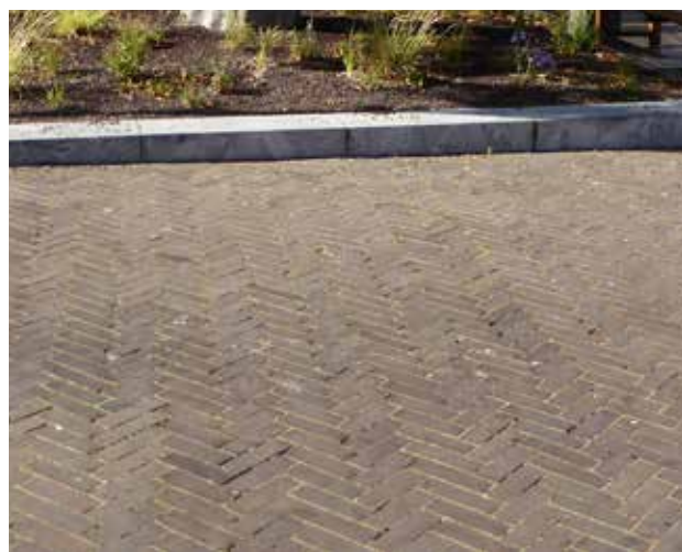
Verharding van het dorpserf bestaat uit gebakken klinkers in keperverband
