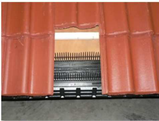
Weergave van een vogelvide. Hierdoor kunnen Huismussen onder dakpannen nestelen, kunnen ze niet het hele dakvlak bereiken en is ventilatie van het dakvlak gewaarborgd.
