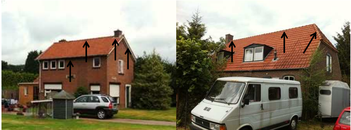
Potentiele verblijfplaatsen in de woningen aan de Binnenweg.
