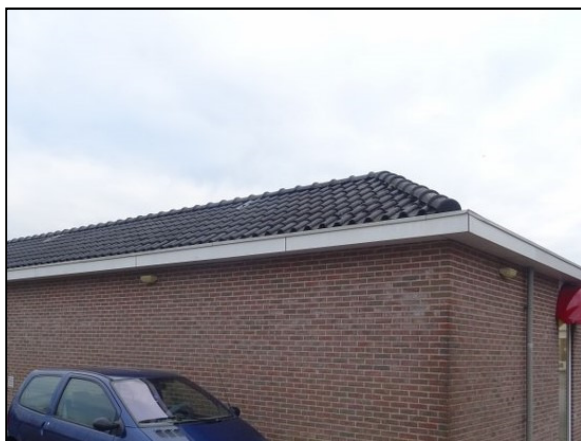
Figuur 13. Dakrand van de kledingwinkel.
