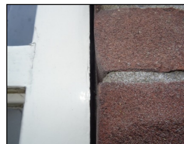
Figuur 24. Open ruimtes naar spouwmuur bij raamkozijn.
