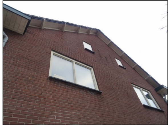
Figuur 15. Dakrand van gebouw aan de linkerzijde van de supermarkt.
