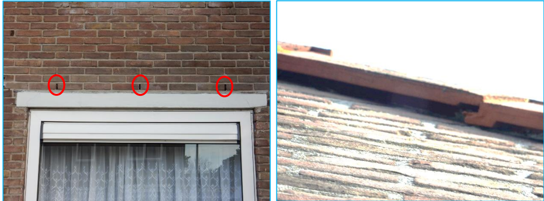
Foto's: Openingen die toegang bieden tot de spouw en de dakconstructie.
