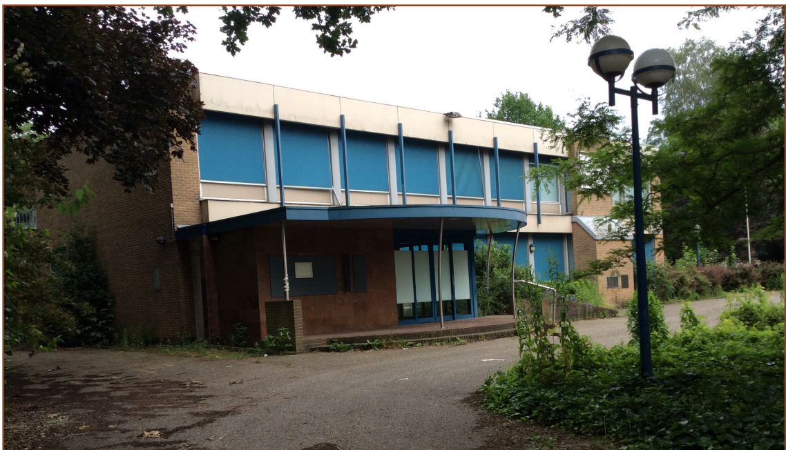
Afb. 1.2: Hoofdingang van het voormalige bankgebouw, gezien vanaf de Rijksstraatweg.
