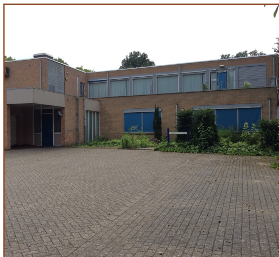
Afb. 3.4: Achterzijde gebouw. De oostelijke helft van het projectgebied is grotendeels verhard en ingericht als parkeerterrein.
