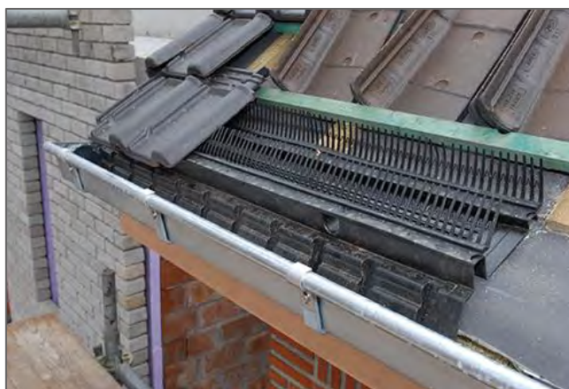
Figuur 3.2. Huismusvide ingebouwd onder de onderste rij dakpannen (vogelbescherming.be)
