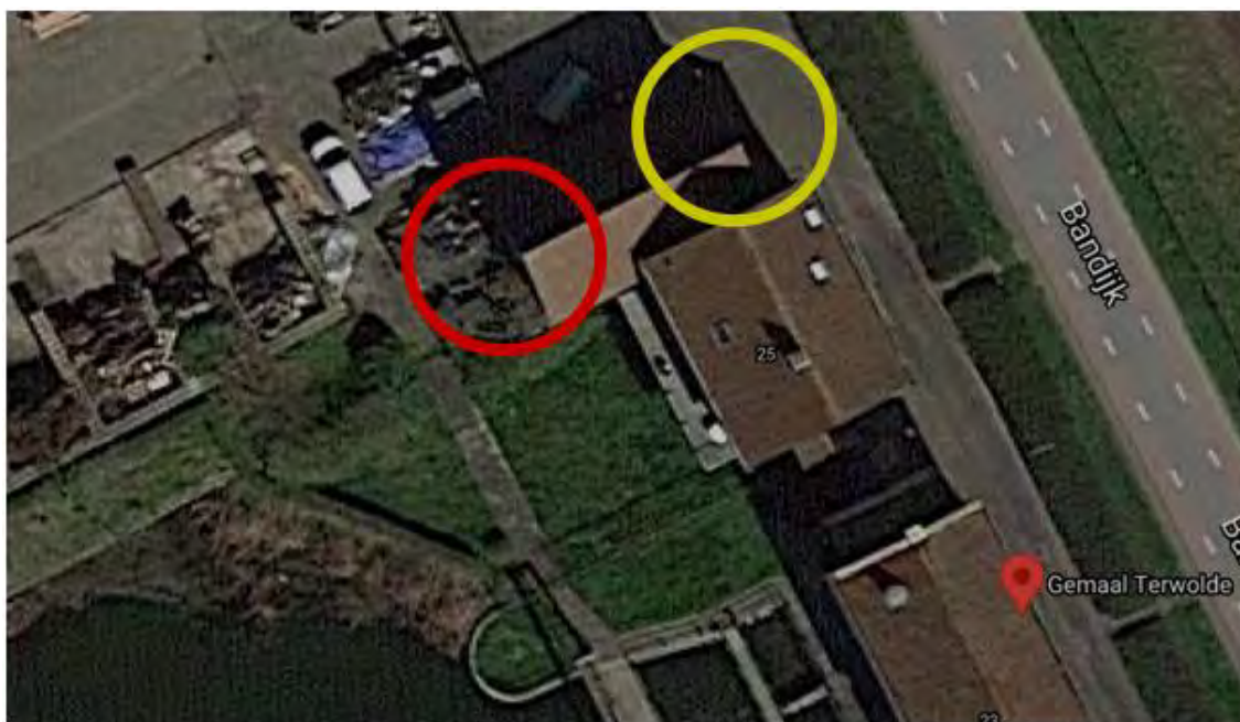
Afbeelding 3.2. Locaties van huiszwaluwnesten (gele cirkel) en verblijfplaatsen van gierzwaluw en gewone dwergvleermuis (rode cirkel) aan de gevels van de schuur.
