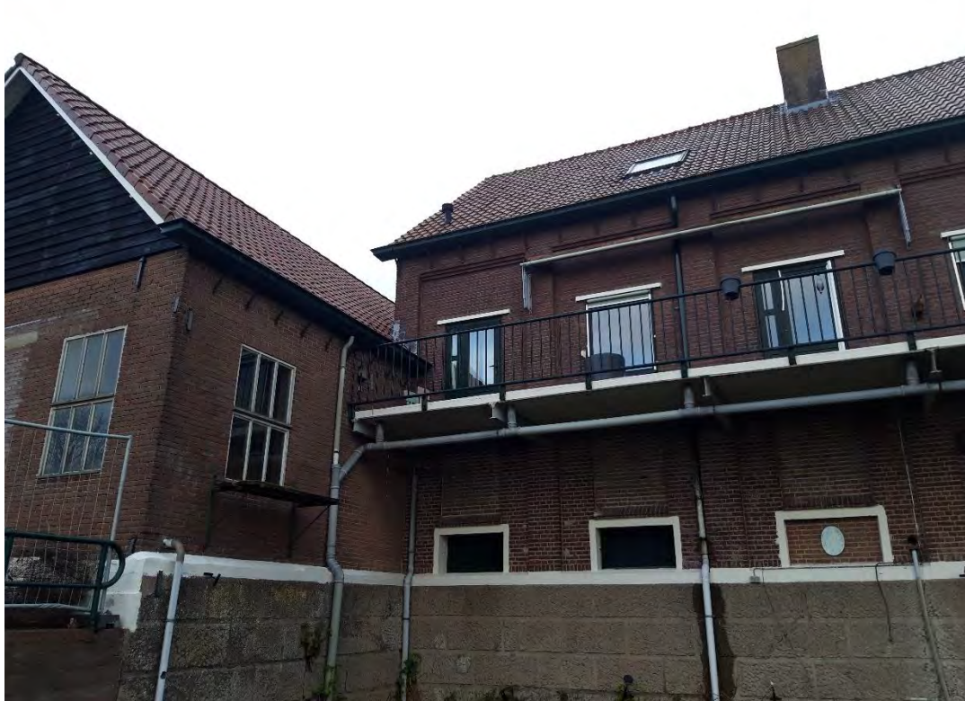
Figuur 13. Het noordelijk gelegen gebouw gezien vanuit de westzijde, de betimmering van de gevel is voldoende toegankelijk voor vleermuizen.
