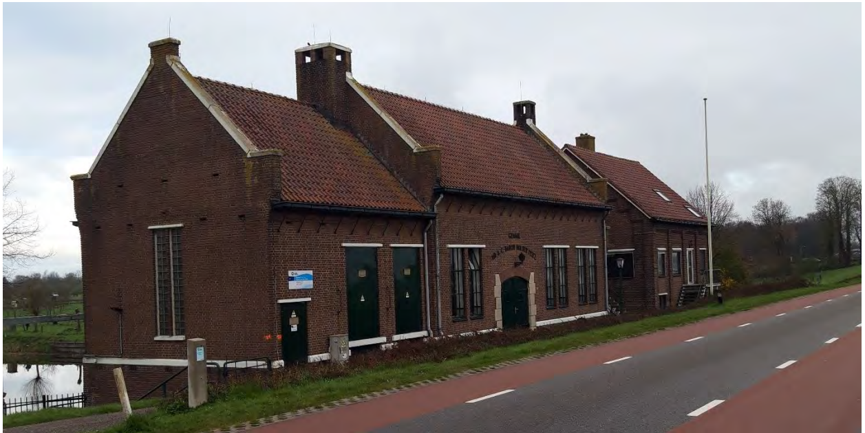
Figuur 1. Bebouwing behorende tot het gemaal vanuit de Bandijk gezien.
