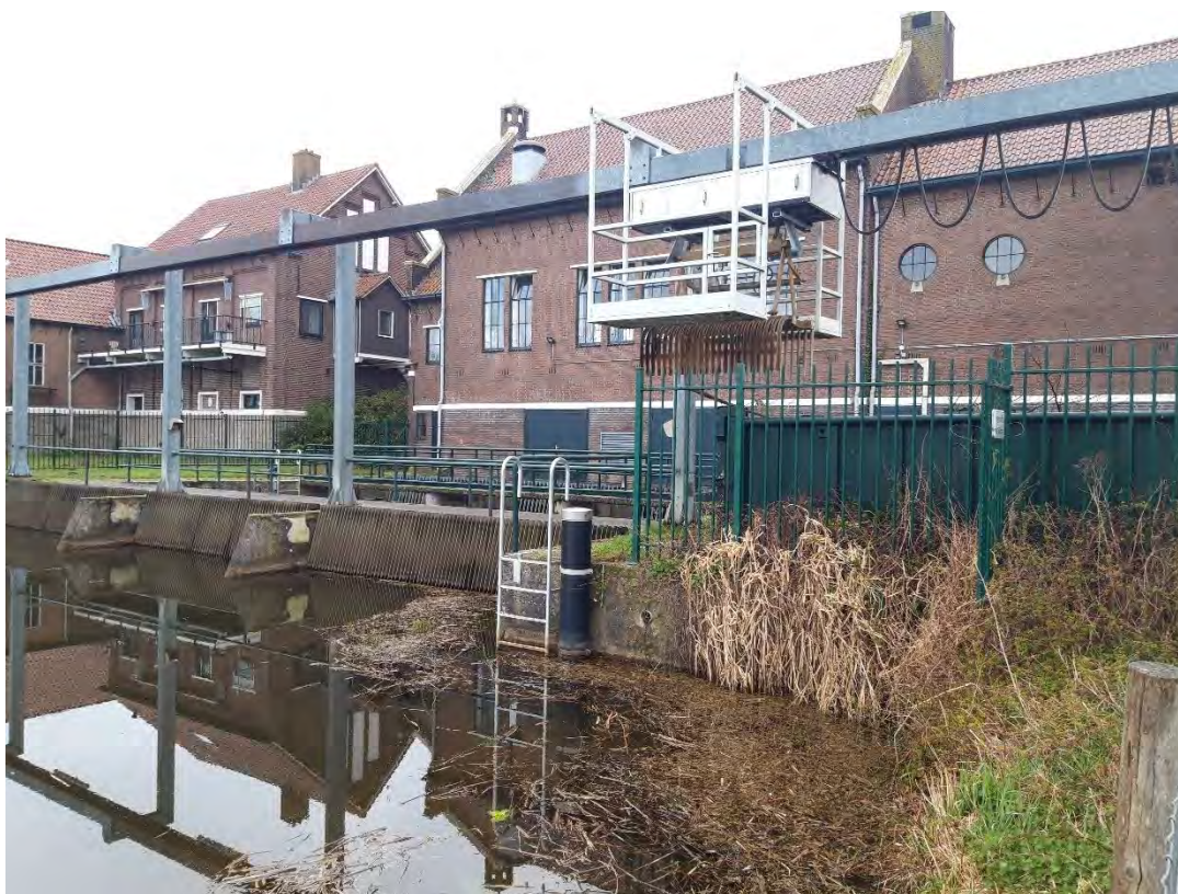
Figuur 10. Impressie van de achterzijde van het gemaal.
