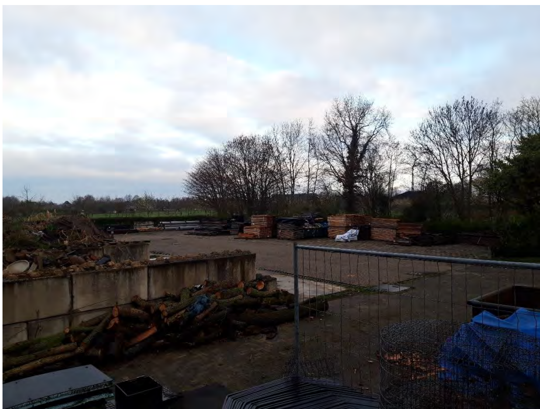
Figuur 11. Impressie van het noordwestelijke deel van het buitenterrein van het gemaal dat wordt gebruikt als opslagplaats.
