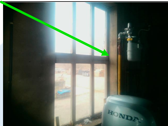
Foto 2 | Bitumen pasta langs kozijn
