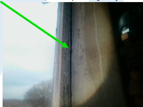
Foto 4 | Bitumen pasta langs kozijn
