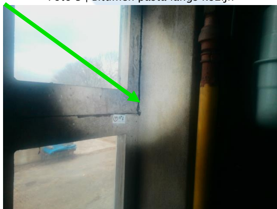
Foto 5 | Bitumen pasta langs kozijn
