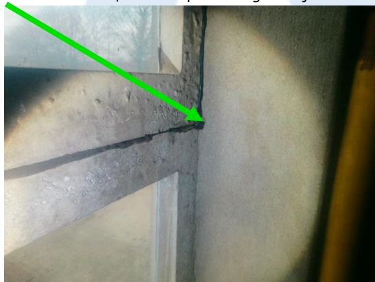
Foto 3 | Bitumen pasta langs kozijn
