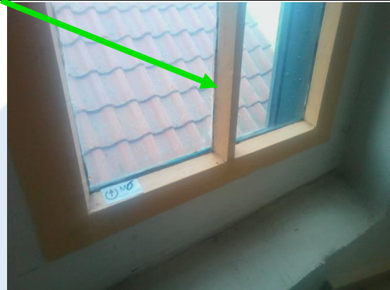
Foto 21 | Beglazingskit houten kozijnen
