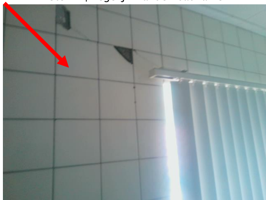
Foto 24 | Tegellijk wanden badkamer
