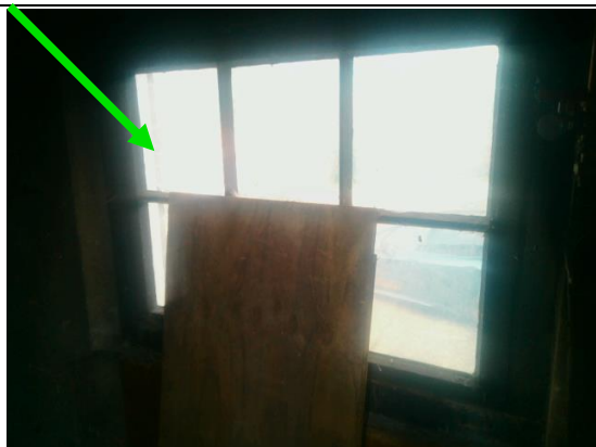
Foto 7 | Beglazingskit houten kozijnen
