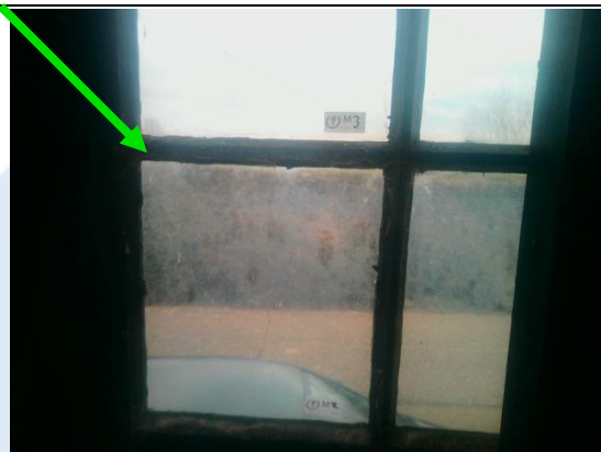
Foto 8 | Beglazingskit houten kozijnen
