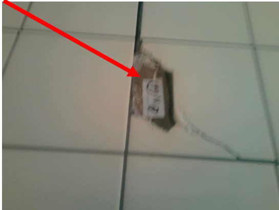
Foto 26 | Tegelijk wanden badkamer
