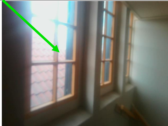
Foto 20 | Beglazingskit houten kozijnen
