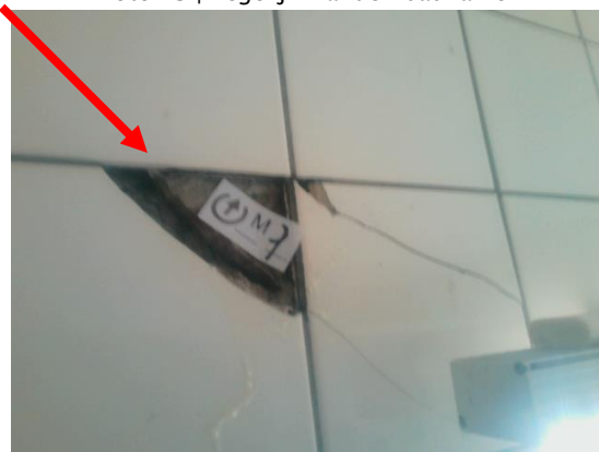
Foto 25 | Tegellijk wanden badkamer
