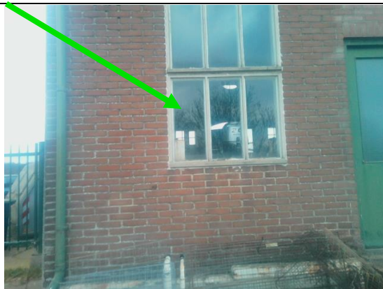
Foto 1 | Bitumen pasta langs kozijn
