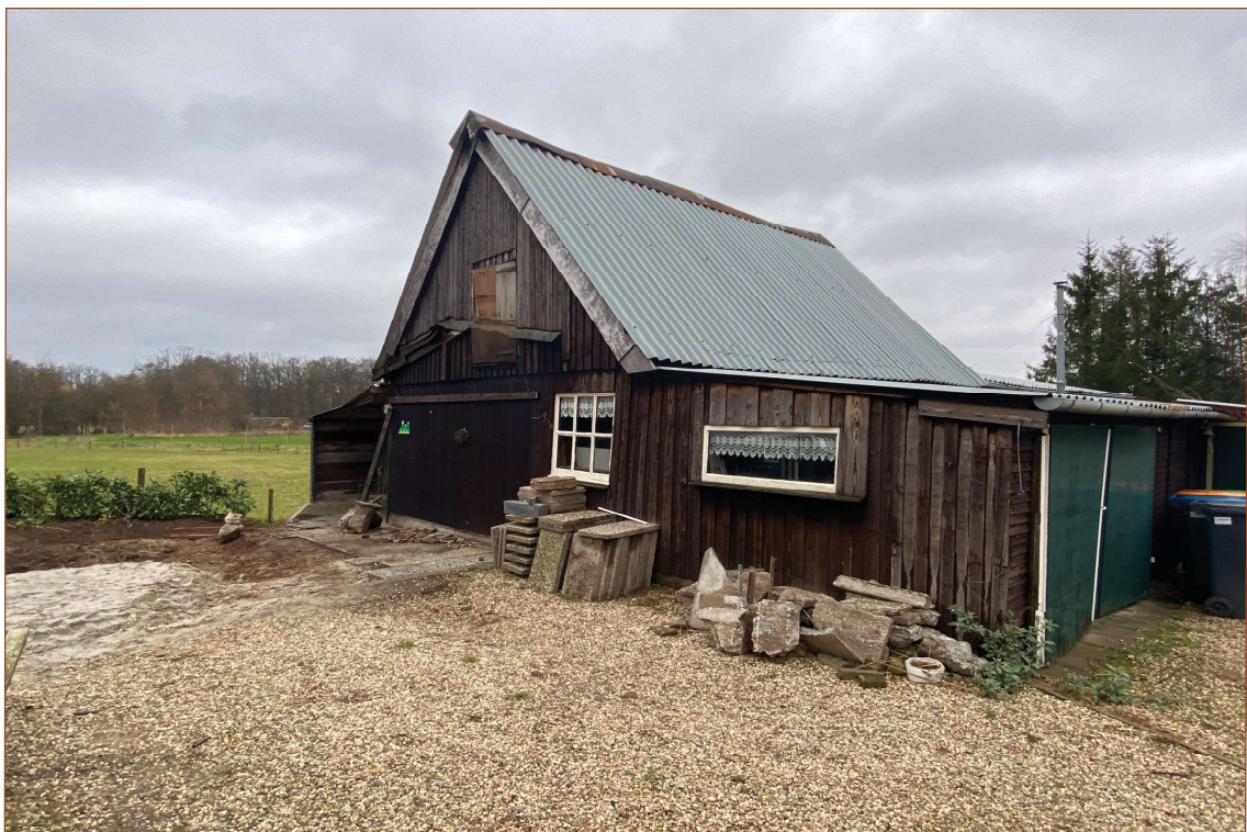
Afb. 1.4 - De te slopen schuur met aanbouw. Op de achtergrond zijn de aanliggende weides zichtbaar. Opnamedatum: 17 februari 2023
