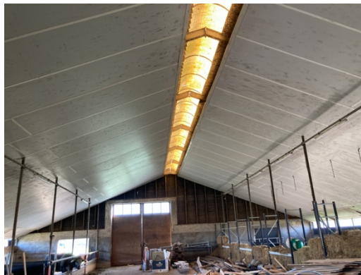
Overblijvend deel van de stal die aansluit op het woonhuis. Het dak is hier niet geschikt om beschermde soorten te herbergen.
