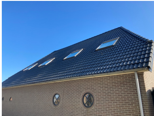
Dakvlak van te behouden gebouw. Nabij de dakkapellen zaten meerdere huismussen te nestelen. De werkzaamheden hebben hier geen invloed op.
