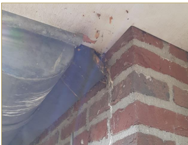
Afbeelding 2.3 – Onder het pannendak is op meerdere plaatsen nestmateriaal aangetroffen. Nesten van huismus kunnen niet worden uitgesloten.
