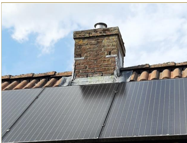
Afbeelding 2.5 – De stootvoegen in de schoorsteen bieden mogelijk toegang tot vaste verblijven van vleermuizen. Zorgvuldige inspectie heeft uitgewezen dat er geen vleermuizen aanwezig zijn of zijn geweest.
