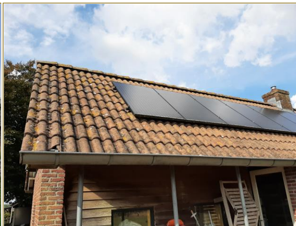
Afbeelding 2.2 – Via de dakgoten zijn de holle ruimtes onder de dakpannen bereikbaar voor huismus.
