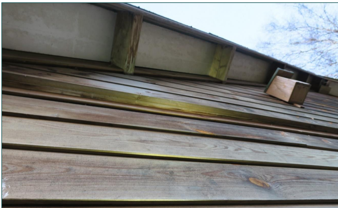
Figuur 3.2 De bedrijfsruimte is opgebouwd uit houten schroten. Deze sluiten veelal strak op elkaar aan, waardoor geschikte kieren die als invliegopening gebruikt kunnen worden ontbreken.
