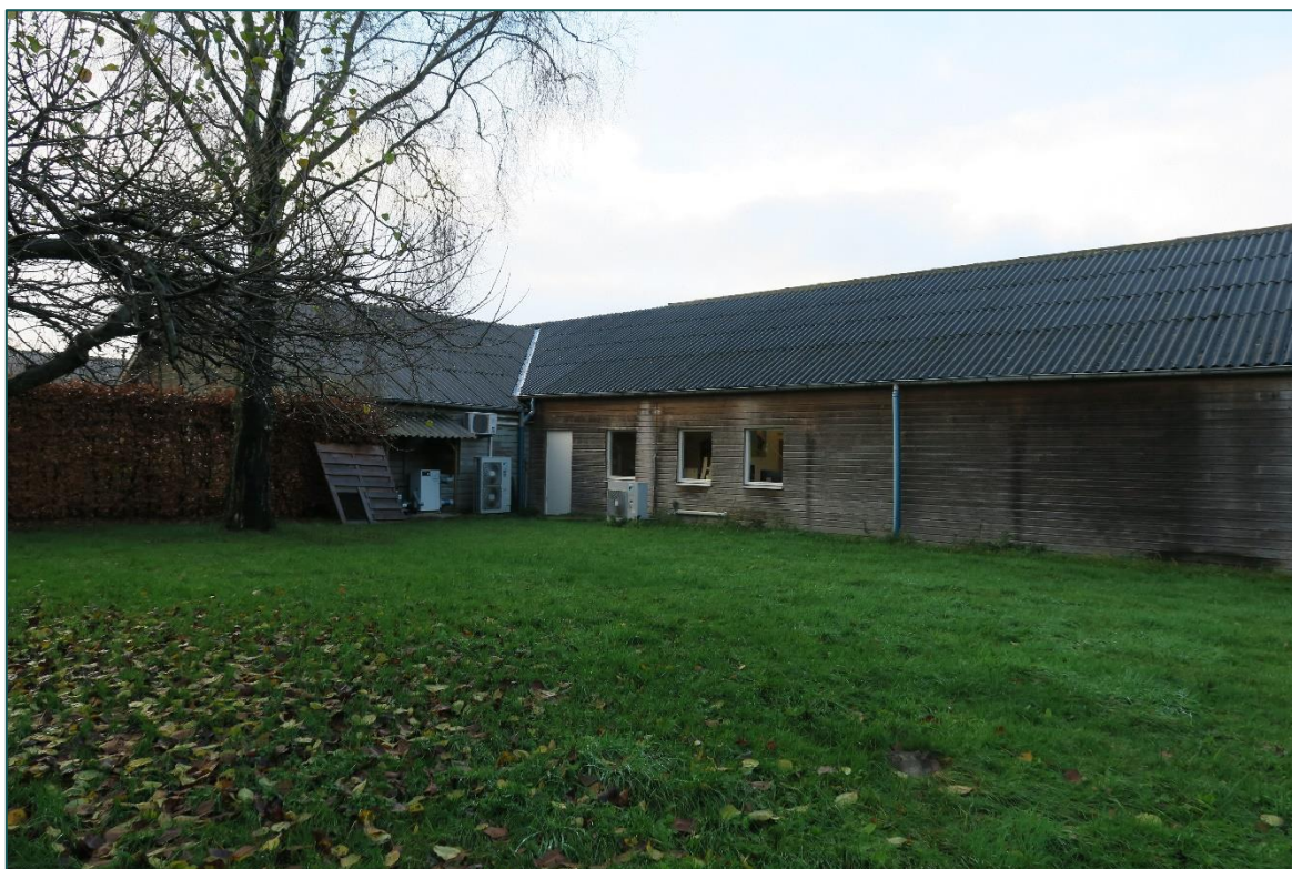
Figuur 1 De te slopen bedrijfsruimte.
