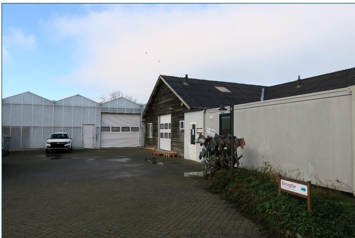
Figuur 2 De te slopen bedrijfsruimte en de keet.
