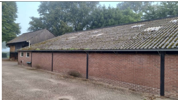
Zuidzijde van schuur met klinkerverharding
