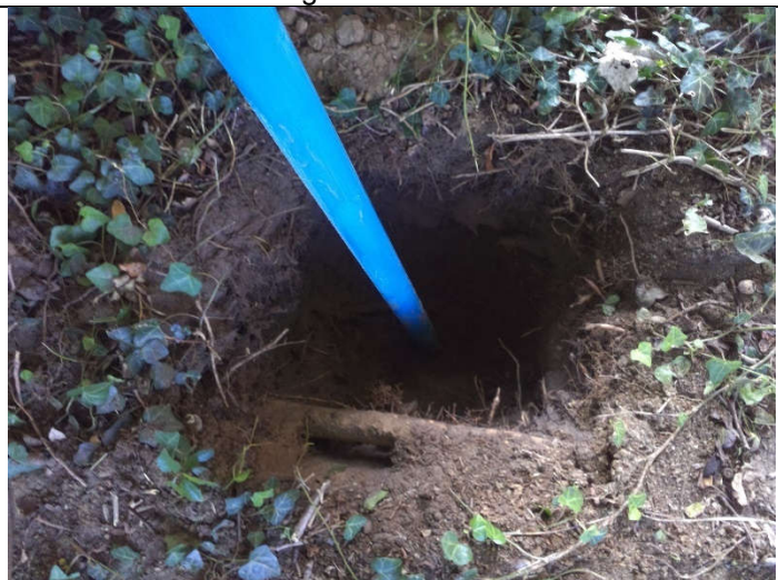
Asbestgat + peilbuis boring 1
