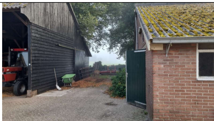
Westzijde schuur. T.p.v. licht grijze verharding heeft een dieseltank met lekbak gestaan.
