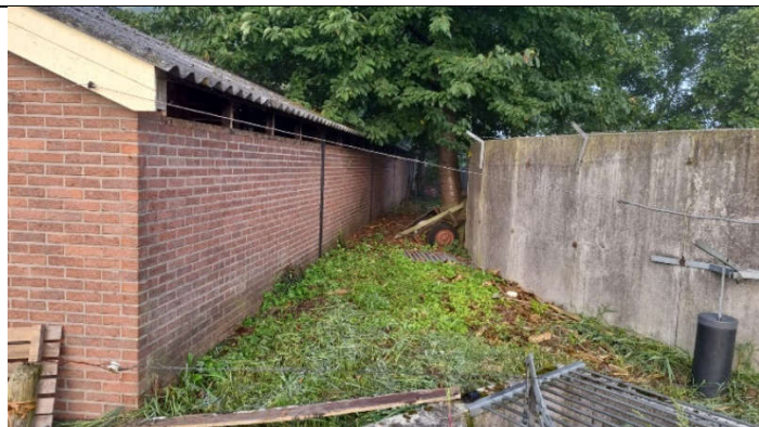
Noordzijde van schuur. Schuur bevat aan deze kant geen dakgoot.
