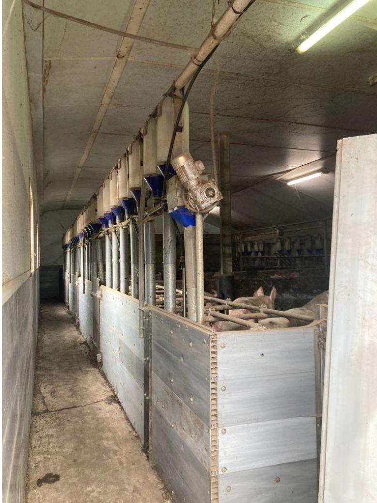
• Afbeelding 17: te slopen schuur
