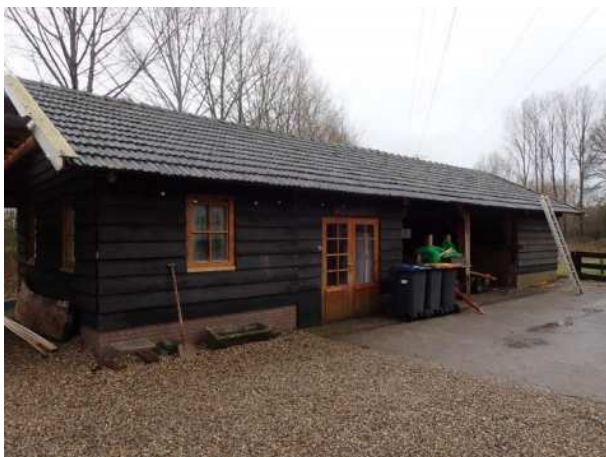
Foto 1: links, de kapschuur.
