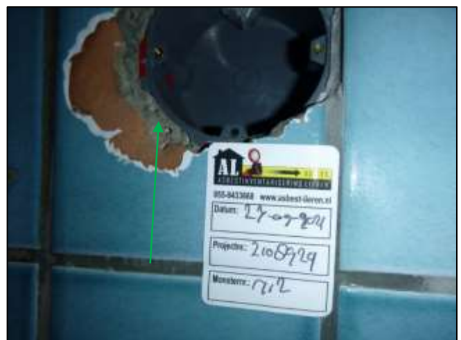
Foto 102: Badkamer, wanden: Tegellijm (Bron 11) (Niet asbesthoudend)
