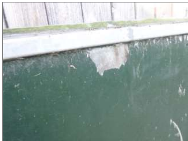
Foto 58: Schuur 3: Deurbeplating (Niet asbestverdacht)
