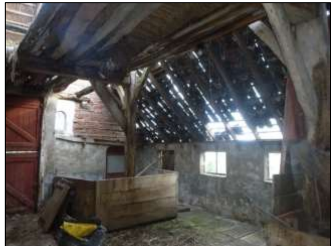
Foto 40: Schuur 2: Tussenschot (Niet asbestverdacht)
