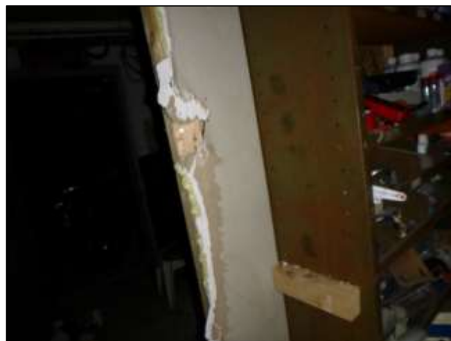
Foto 32: Schoor 1, begane grond: Vlakke plaat (Niet asbestverdacht)
