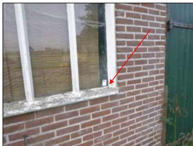
Foto 54: Schuur 1 & 2, betonnen kozijnen (enkel glas): Beglazingskit (Bron 4) (Asbesthoudend)
