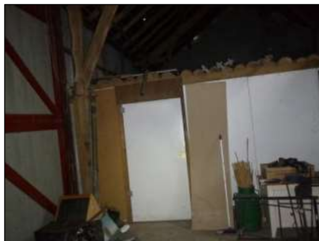
Foto 34: Schoor 1, begane grond: Wandbeplating (Niet asbestverdacht)
