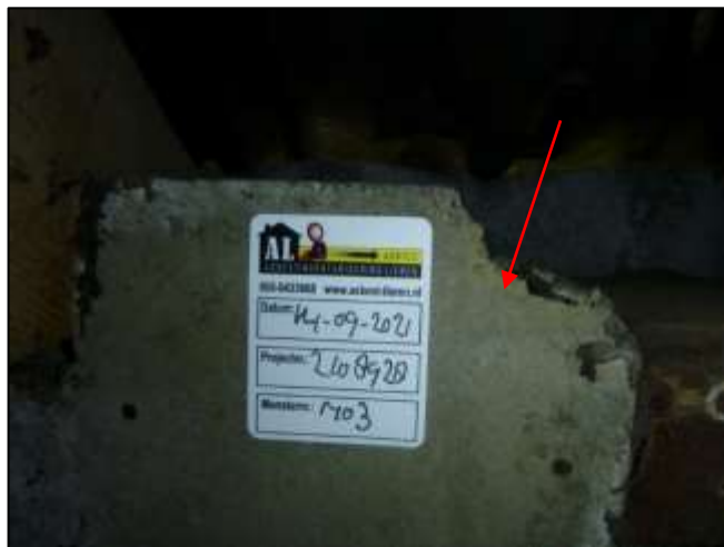
Foto 16: Schuur 1, verdieping: Vlakke plaat (Bron 3) (Asbesthoudend)
