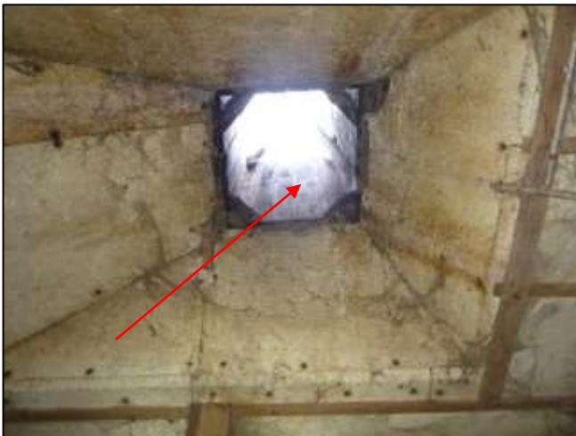
Foto 69: Schuur 3, dak: Ontluchtingskokers (Bron 21) (Asbesthoudend)
