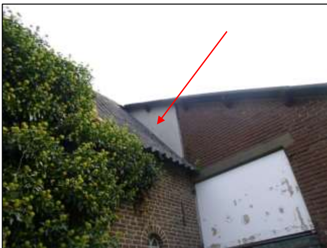
Foto 47: Gevel schuur 1: Vlakke plaat (Bron 19) (Asbesthoudend)
