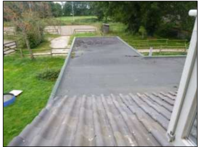
Foto 86: Afdak: Dakleer (Niet asbestverdacht)
