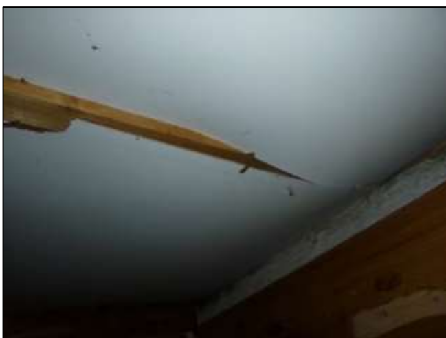
Foto 35: Schoor 1, begane grond: Plafondbeplating (Niet asbestverdacht)
