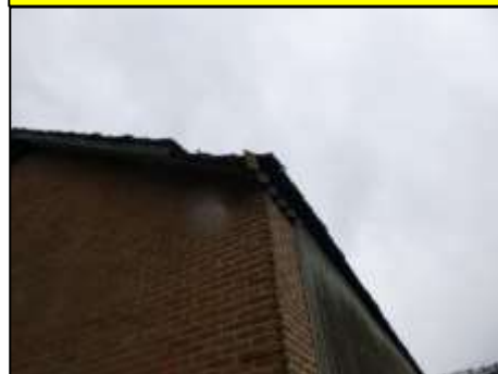
Overstek schuur 1: Vlakke plaat (Bron 20) (Asbesthoudend)
