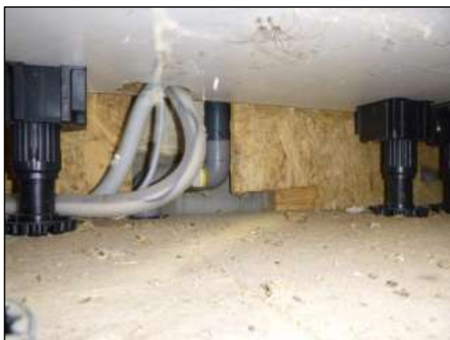
Foto 95: Keuken: Onder keukenblok (Niet asbestverdacht)
