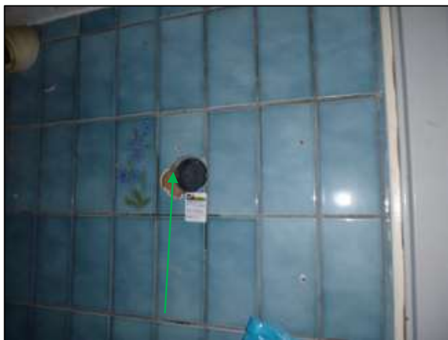
Foto 103: Badkamer, wanden: Tegellijm (Bron 11) (Niet asbesthoudend)
