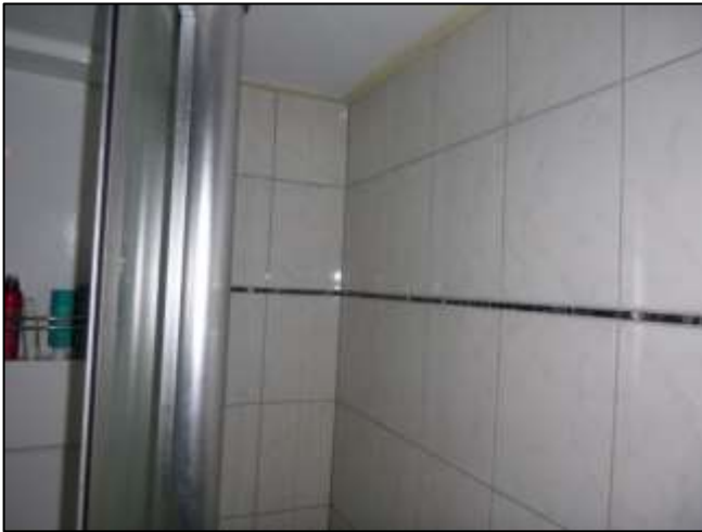
Foto 109: Badkamer, vloer & wanden: Tegellijn (Niet asbestverdacht)
