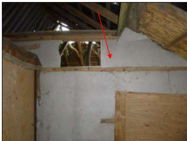
Foto 18: Schuur 1, verdieping: Vlakke plaat (Bron 3) (Asbesthoudend)
