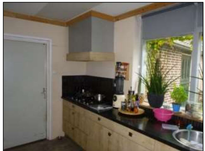
Foto 100: Keuken: Ventilatiekanaal (Niet asbestverdacht)
