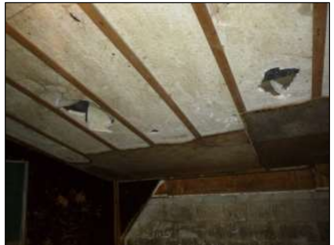
Foto 70: Schuur 3: Isolatiemateriaal (Niet asbestverdacht)
