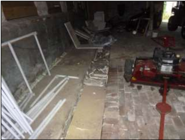
Foto 37: Schuur 2: Restanten vlakke plaat (Niet asbestverdacht)
