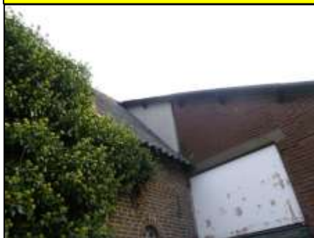
Gevel schuur 1: Vlakke plaat (Bron 19) (Asbesthoudend)
