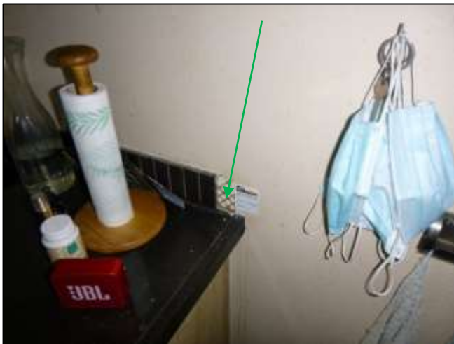
Foto 97: Keuken, wanden: Tegellijm (Bron 10) (Niet asbesthoudend)
