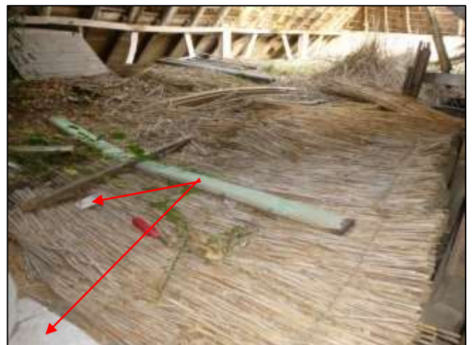
Foto 24: Schuur 1 & 2, verdieping: Restanten vlakke plaat (Bron 18) (Asbesthoudend)
