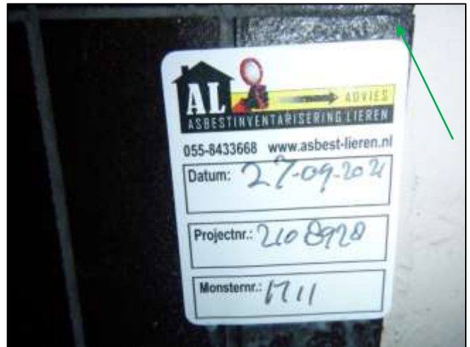
Foto 98: Keuken, wanden: Tegellijm (Bron 10) (Niet asbesthoudend)
