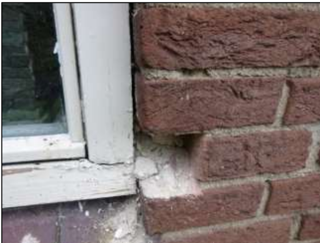
Foto 111: Buitengevels: Spouwonderzoek (Niet asbestverdacht)
