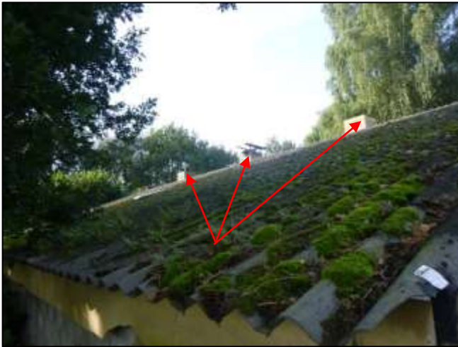
Foto 67: Schuur 3, dak: Ontluchtingskokers (Bron 21) (Asbesthoudend)
