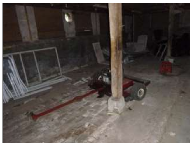
Foto 36: Schoor 2: Vloerafwerking (Niet asbestverdacht)
