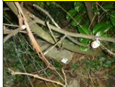
Maaiveld tussen schuur 4 en de weg: Vlakke plaat (Bron 8) (Asbesthoudend)
