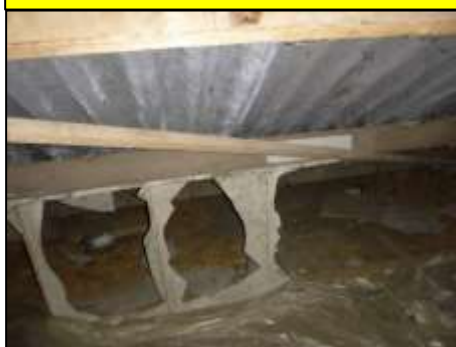
Schuur 1, verdieping: Restanten vlakke plaat (Bron 17) (Asbesthoudend)
