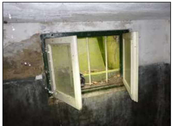
Foto 90: Kelder: Beglazingskit (Niet asbestverdacht)
