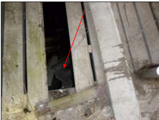
Foto 45: Schuur 2, begane grond & mestput: Restanten golfplaat & vlakke plaat (Bron 16) (Asbesthoudend)
