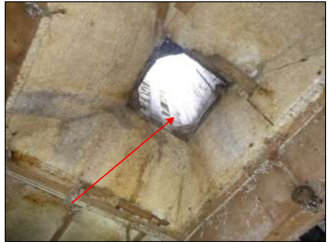
Foto 68: Schuur 3, dak: Ontluchtingskokers (Bron 21) (Asbesthoudend)
