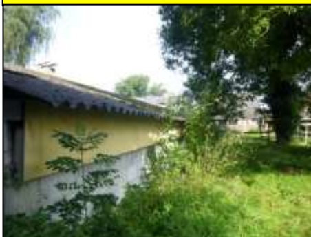
Schuur 3, zijgevels: Vlakke plaat (Bron 5) (Asbesthoudend)
