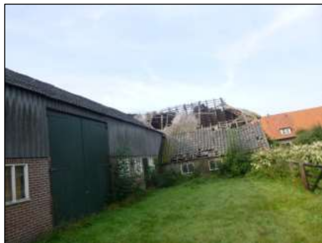
Foto 50: Schuur 2: Dakpannen (Niet asbestverdacht)
