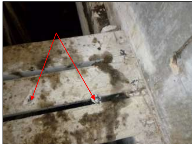
Foto 44: Schuur 2, begane grond & mestput: Restanten golfplaat & vlakke plaat (Bron 16) (Asbesthoudend)
