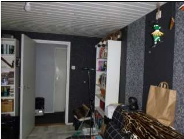
Foto 87: Slaapkamer: Plafondafwerking (Niet asbestverdacht)
