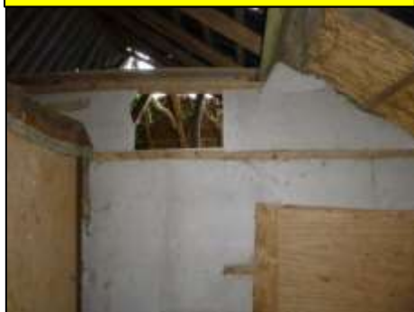
Schuur 1, verdieping: Vlakke plaat (Bron 3) (Asbesthoudend)
