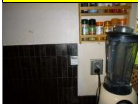
Keuken, wanden: Tegellijm (Bron 10) (Niet asbesthoudend)
