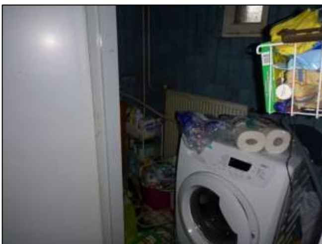
Foto 101: Badkamer: Radiator (Niet asbestverdacht)
