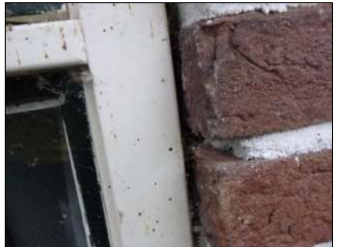
Foto 112: Buitengevels: Spouwonderzoek (Niet asbestverdacht)
