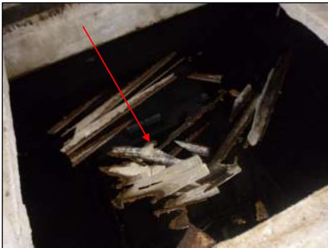
Foto 43: Schuur 2, begane grond & mestput: Restanten golfplaat & vlakke plaat (Bron 16) (Asbesthoudend)
