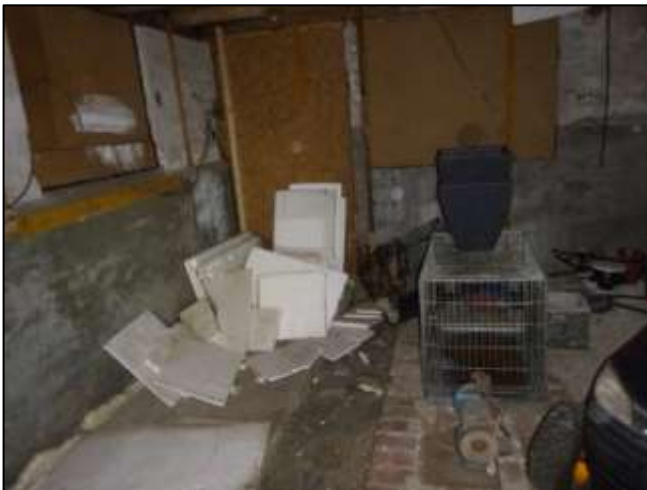
Foto 39: Schuur 2: Restanten vlakke plaat (Niet asbestverdacht)
