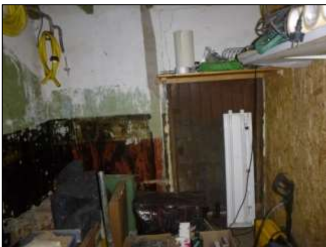
Foto 33: Schoor 1: Wandafwerking (Niet asbestverdacht)
