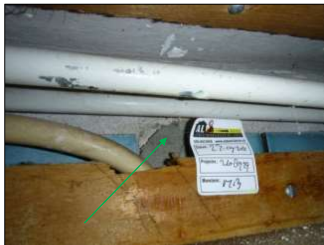
Foto 104: Badkamer, wanden: Tegellijm (Bron 11) (Niet asbesthoudend)
