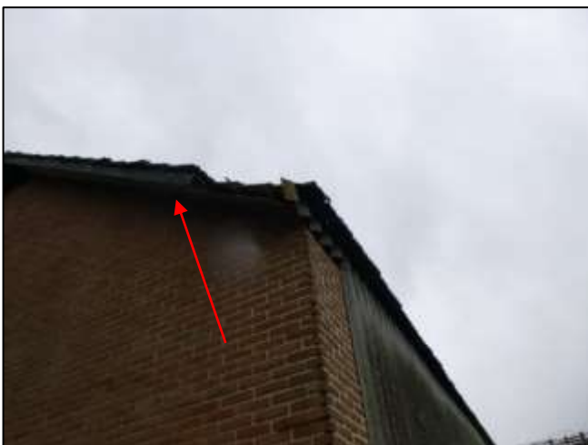
Foto 113: Overstek schuur 1: Vlakke plaat (Bron 20) (Asbesthoudend)
