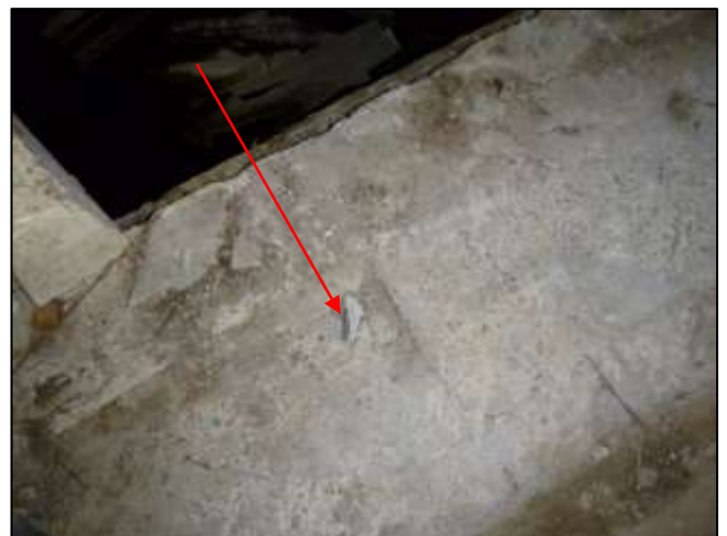
Foto 42: Schuur 2, begane grond & mestput: Restanten golfplaat & vlakke plaat (Bron 16) (Asbesthoudend)
