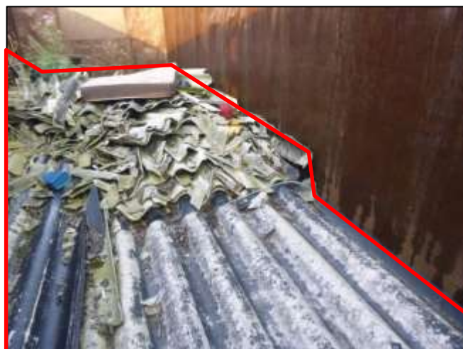
Foto 10: In een container: Golfplaten & restanten plaatmateriaal (Bron 1) (Asbesthoudend)
