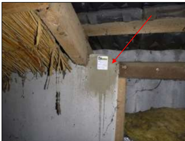
Foto 17: Schuur 1, verdieping: Vlakke plaat (Bron 3) (Asbesthoudend)
