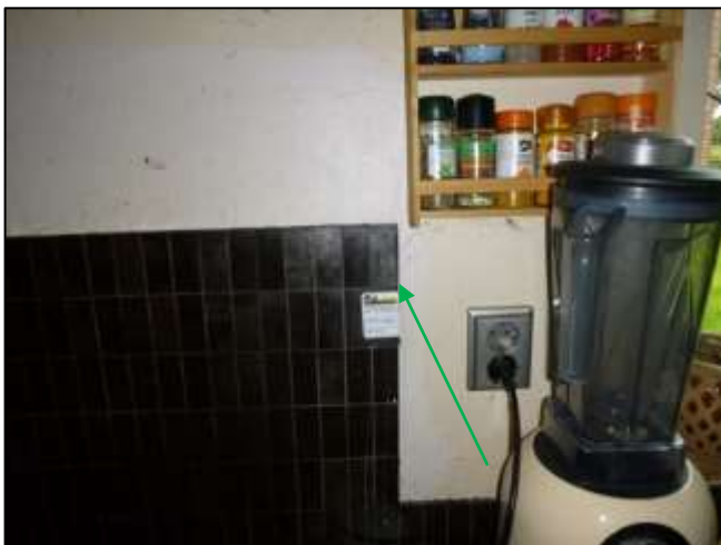
Foto 99: Keuken, wanden: Tegellijm (Bron 10) (Niet asbesthoudend)
