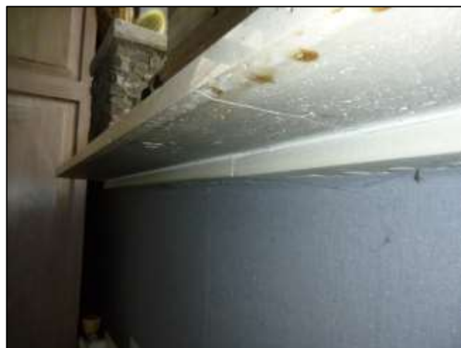
Foto 94: Woonkamer: Vensterbank (Niet asbestverdacht)
