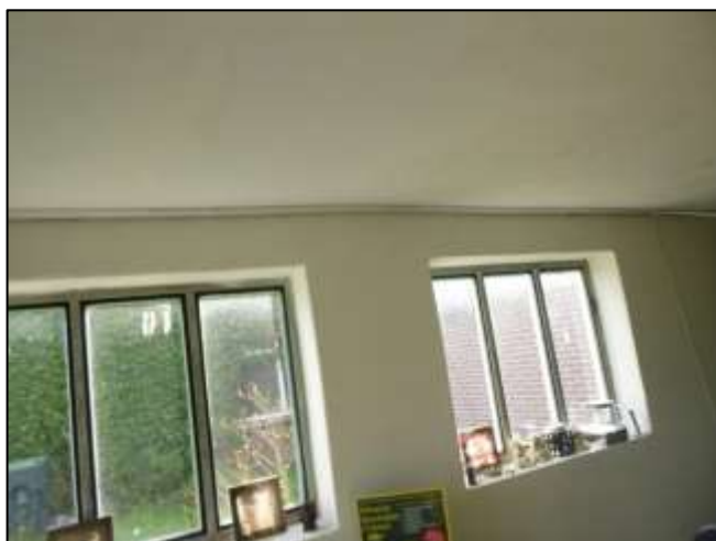
Foto 51: Praktijk: Plafondafwerking (Niet asbestverdacht)
