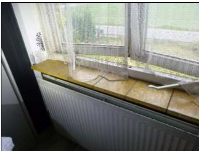
Foto 89: Slaapkamer: Vensterbank (Niet asbestverdacht)
