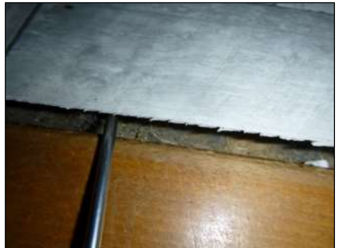
Foto 88: Slaapkamer: Onder vloerafwerking (Niet asbestverdacht)
