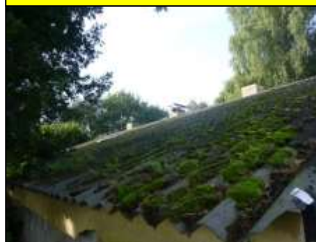
Schuur 3, dak: Ontluchtingskokers (Bron 21) (Asbesthoudend)
