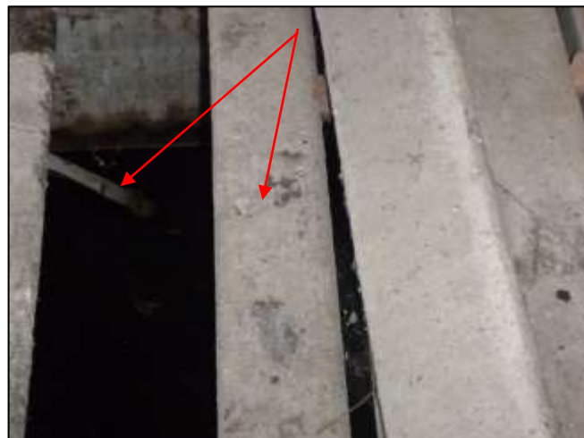
Foto 46: Schuur 2, begane grond & mestput: Restanten golfplaat & vlakke plaat (Bron 16) (Asbesthoudend)
