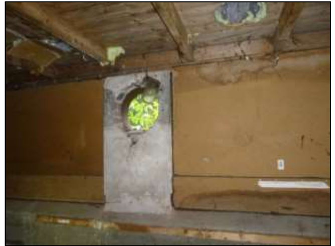
Foto 38: Schuur 2: Wandbeplating (Niet asbestverdacht)
