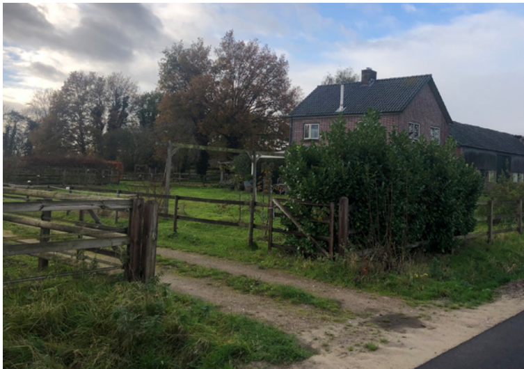
Afbeelding 8. Te slopen woning en meest oostelijke inrit van het erf.
