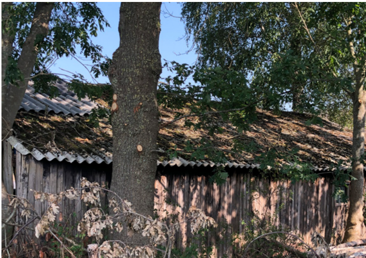
Afbeelding 12. Te slopen schuur
