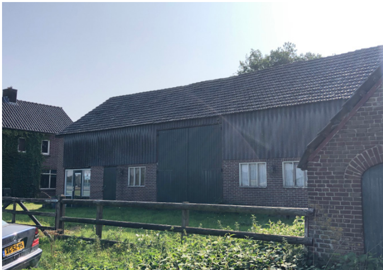
Afbeelding 11. Te slopen schuur
