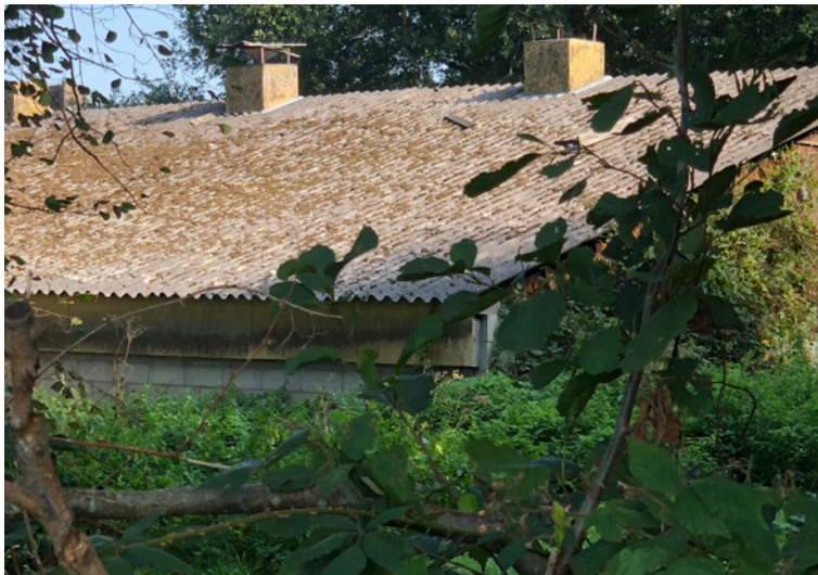
Afbeelding 13. Te slopen schuur
