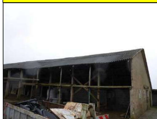
Schuur 1: Golfplaten dak (M01AA)
