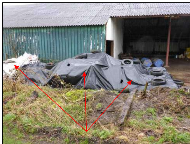
Foto 24: Naast schuur 1: Golfplaat & vlakke plaat (M04AA & M05AA)
