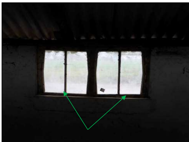
Foto 15: Schuur 1: Stopverf (M02V & M03V)
