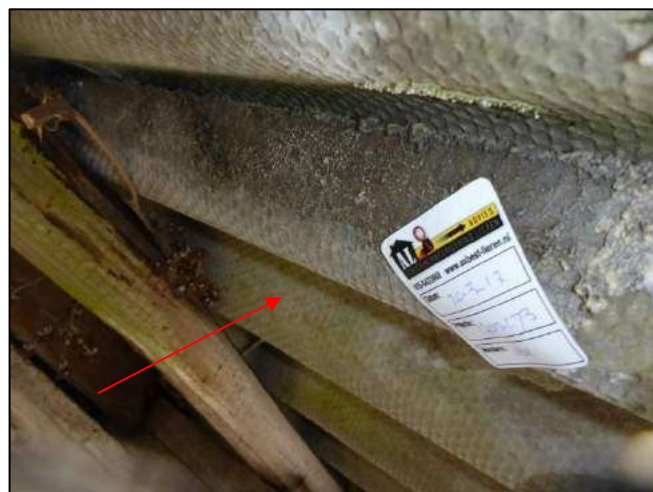
Foto 10: Schuur 1: Golfplaten dak (M01AA)
