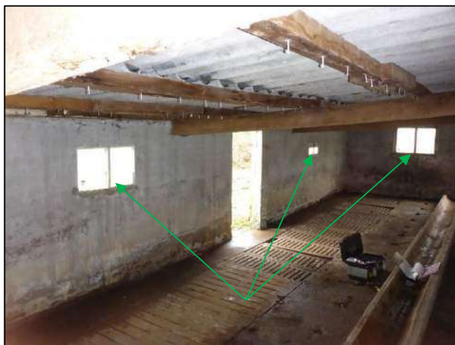
Foto 37: Schoor 2: Stopverf (M06V & M07V)
