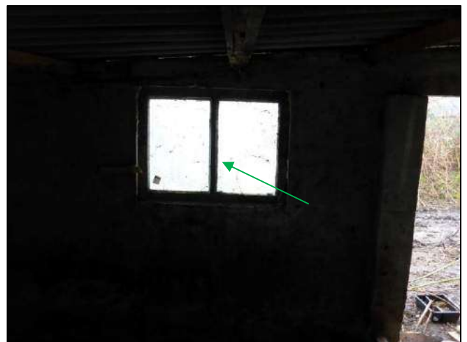
Foto 36: Schuur 2: Stopverf (M06V & M07V)
