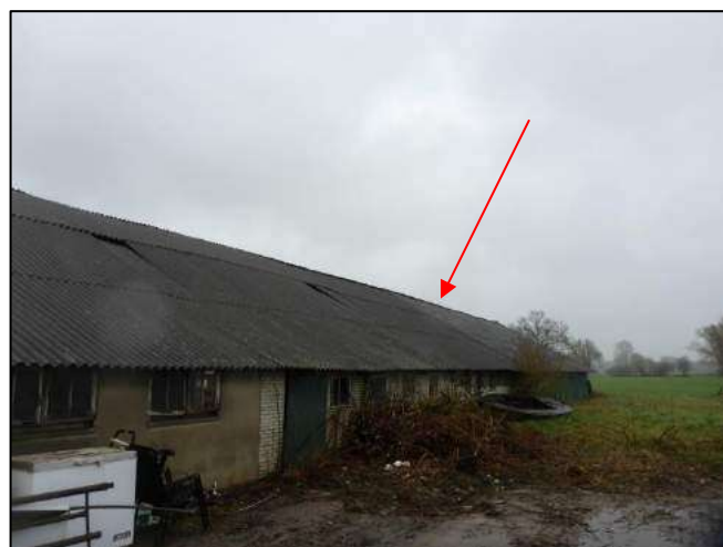
Foto 12: Schuur 1: Golfplaten dak (M01AA)
