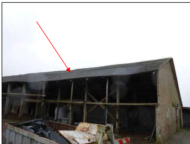
Foto 13: Schuur 1: Golfplaten dak (M01AA)
