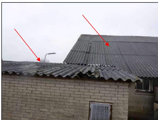
Foto 11: Schuur 1: Golfplaten dak (M01AA)
