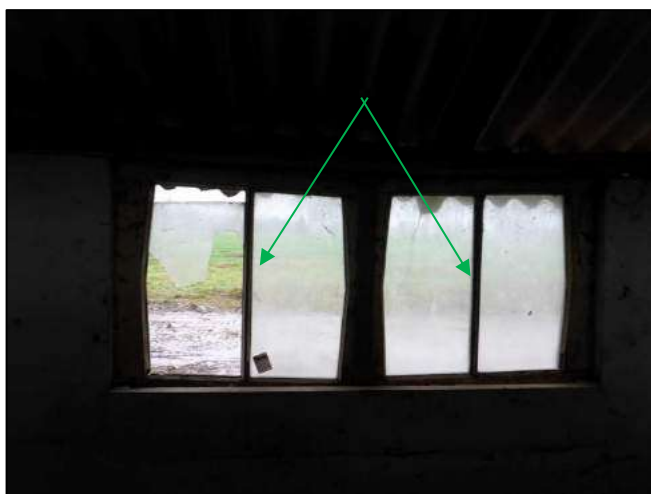
Foto 17: Schuur 1: Stopverf (M02V & M03V)
