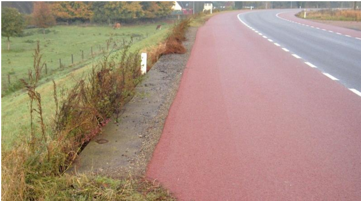
Figuur 5 Betonnen randen met ronde metalen gaten (ten behoeve van het hekwerk) zijn nog de enige zichtbare overblijfselen van het inlaatwerk.
