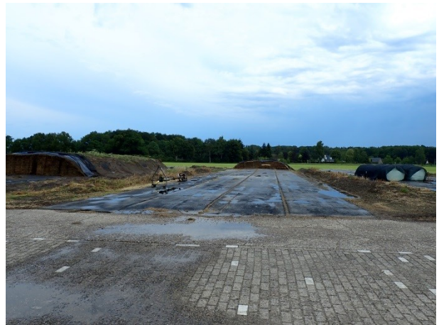
Foto 8 en 9: de opslag voor ruwvoer, met links de betonnen kuilen en rechts de met rubber maten afgedichte opslag.
