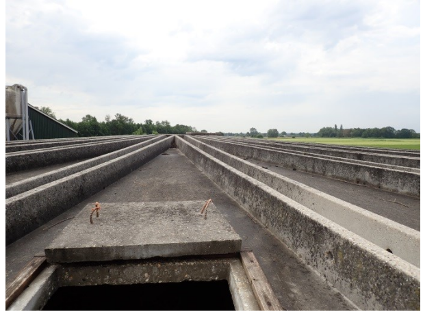
Foto 6 en 7: de betonnen mestilo met rechts het betonnen dak van deze silo met een mangat.
