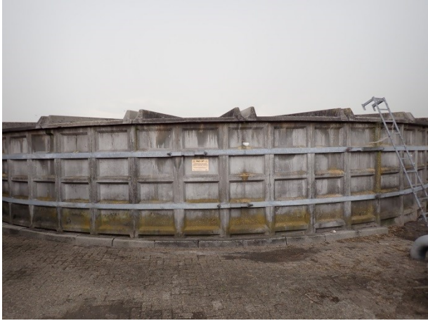
Foto 6 en 7: de betonnen mestilo met rechts het betonnen dak van deze silo met een mangat.
