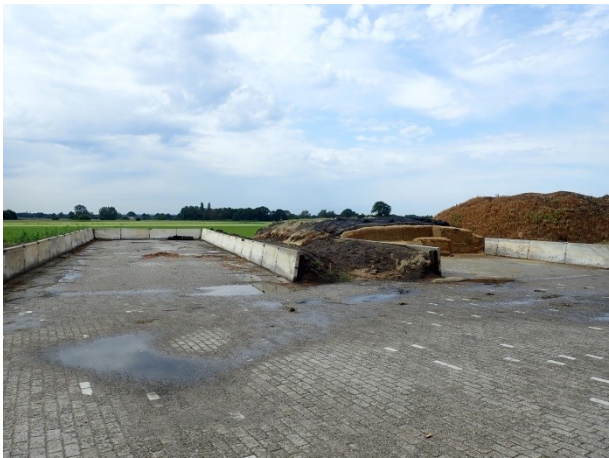
Foto 8 en 9: de opslag voor ruwvoer, met links de betonnen kuilen en rechts de met rubber maten afgedichte opslag.
