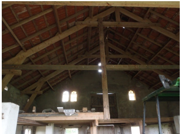
Foto 1 en 2: de varkensschuur aan de buitenzijde en de binnenzijde Op de foto van de binnenzijde is nog juist een klein deel van de zolder zichtbaar. Ook is de niet beschoten kap goed zichtbaar.
