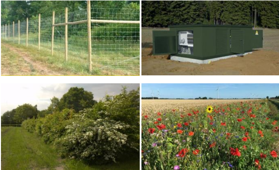
Afbeelding 11: Voorbeeld hekwerk, trafostation, wilde natuurlijke haag en kruidenbeplanting
