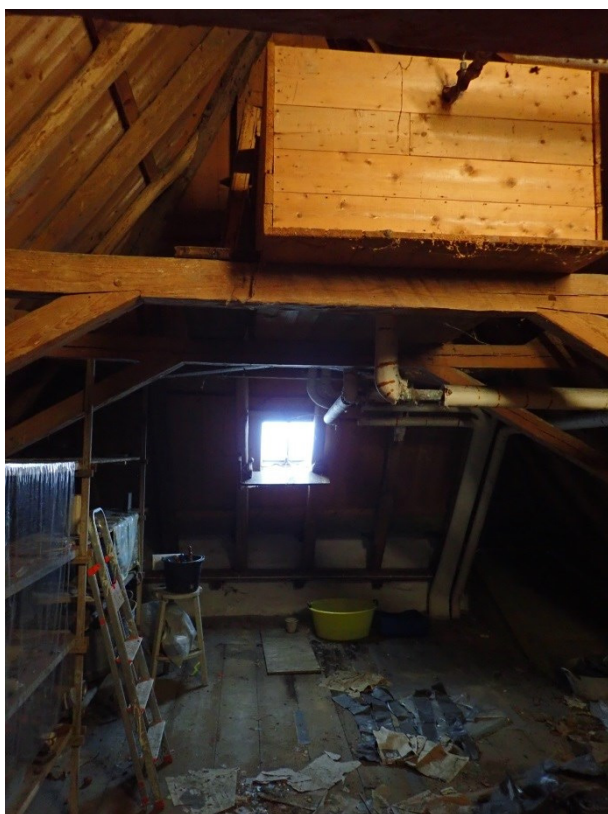
Foto 14: de zolder en kap van het noordelijk bouwdeel van het achterhuis. De kist op de foto is voor de watervoorziening.
