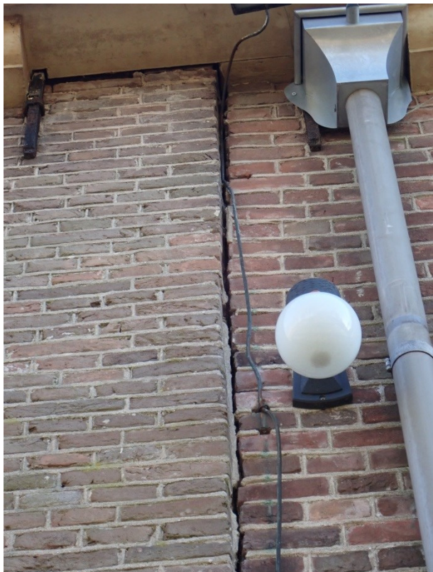
Foto 12: de kiertussen beide delen van het achterhuis en een kleine kier in de dakgoot omlijsting.
