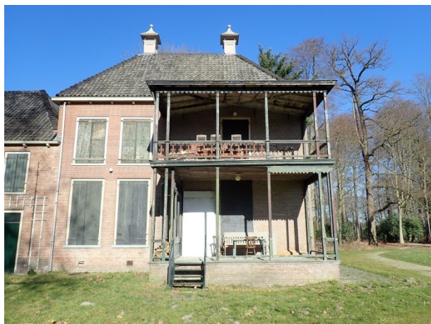
Foto 20: de veranda over twee verdiepingen aan de zuidzijde van het voorhuis.
