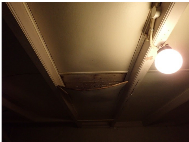
Foto 17: een plafond tussen de balken, in dit geval van zachtboard. Het materiaal is strak tegen de plankenvloer aangebracht.
