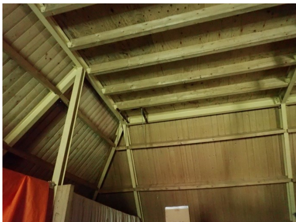
Foto 15: de vernieuwde kapconstructie van het voorhuis.
