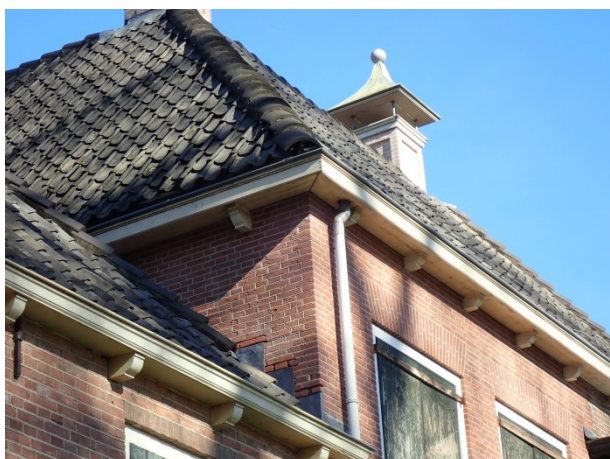
Foto 21: de kap tussen het achter- en voorhuis aan de zuidzijde.
