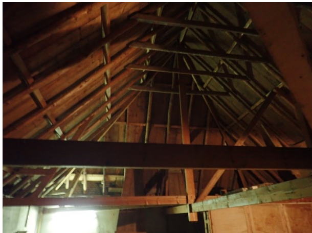
Foto 13: de kapconstructie van het zuidelijk bouwdeel van het achterhuis.
