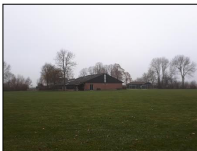
Figuur 7. Ontmoetingsgebouw, gezien vanaf het noordoosten.
