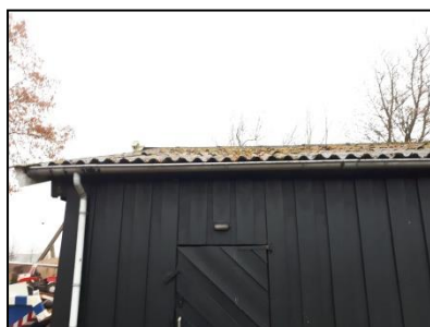
Figuur 12. Schuur aan westzijde onderzoekslocatie, gezien vanaf het oosten.
