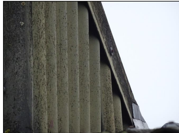
Figuur 25. Ruimte rond dakramen en overkapping ontmoetingsgebouw.
