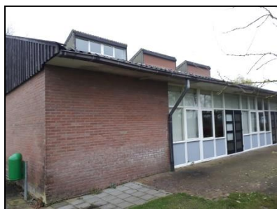
Figuur 3. Ingang ontmoetingsgebouw, gezien vanaf het zuidoosten.
