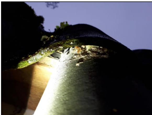
Figuur 22. Ruimte onder dakplaten ontmoetingsgebouw.
