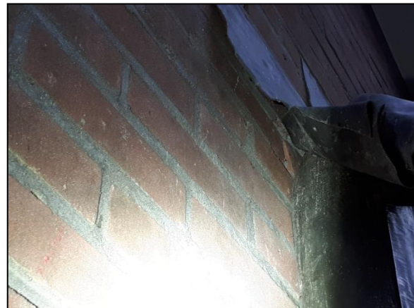
Figuur 26. Ruimte onder loodslabben ontmoetingsgebouw.
