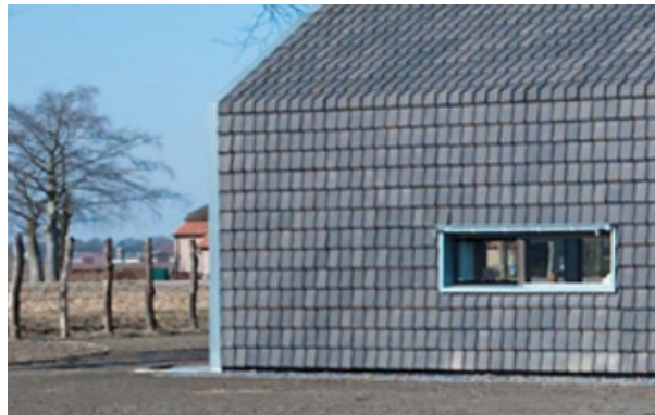
Eenvoudige, donkere dakbedekking
