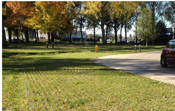
13 - Overloop parkeren op grasbeton
