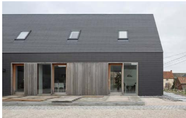
Eenvoudige, donkere dakbedekking
