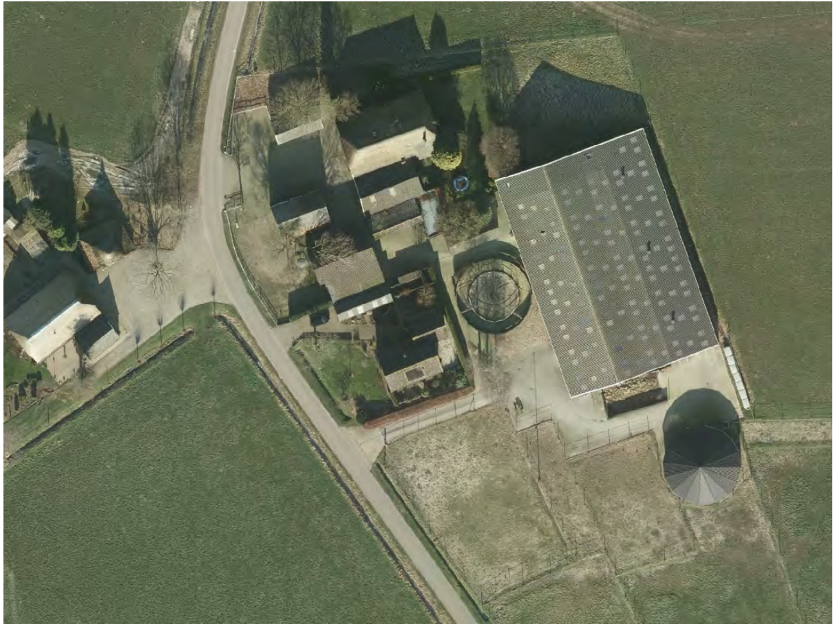
Afbeelding 5 - Luchtfoto bestaand erf
