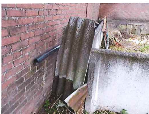
Foto 11: Stukken golfplaat op maaiveld (003)
