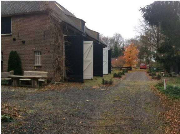
Figuur 8: Overzichtsfoto bebouwing
