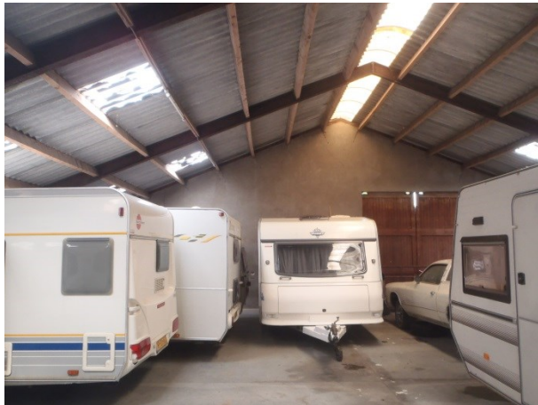
Foto 1: het interieur van de voormalige loopstal. De constructie van het dak is goed zichtbaar. Nergens zijn schuilgelegenheden voor diersoorten aanwezig.
