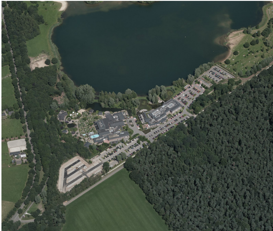
Afbeelding 2 - Luchtfoto van het perceel
