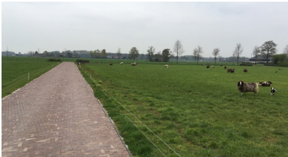
BESTAAND STRAATWERK OPRIT
