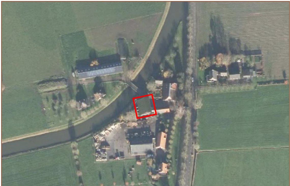
Afb. 1.1: Het onderzoeksgebied vanuit de lucht gezien. Het rode kader geeft de locatie van de te verbouwen veldschuur weer. Bron ondergrond: PDOK.
