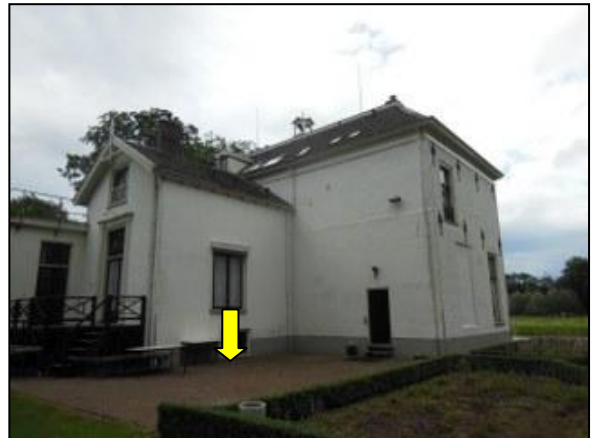
Figuur 4. Uitbreidingslocatie, achterzijde hoofdgebouw.
