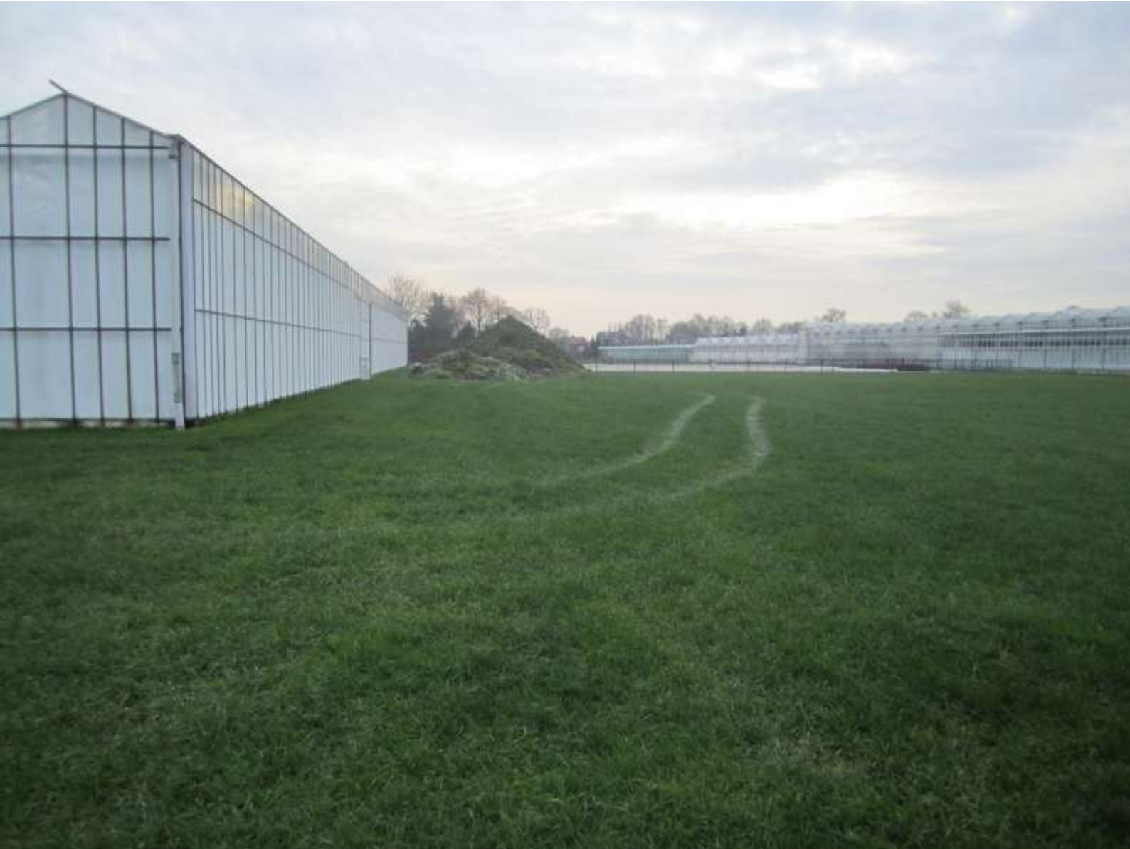
Foto 1. De beoogde bouwplaats vanuit het noordwesten gezien. Links de uit te breiden kas van Haarman, rechts het kassencomplex van Polman. Door de landschappelijk besloten ligging van de bouwplaats heeft deze geen potenties als broedplaats voor vogels.
