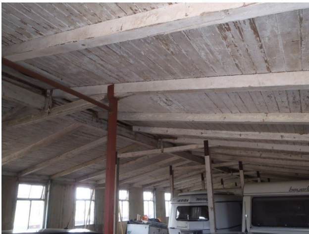
Foto 3: het interieur van de houten loods. De balken die in het dak zichtbaar zijn hebben aan de bovenzijde een smalle opening die met de endoscoop is geïnspecteerd.
