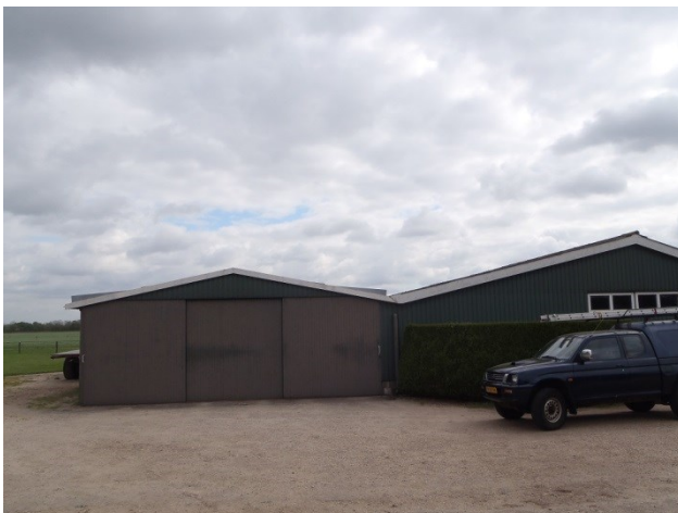
Foto 6: links de houtenschuur en rechts is de stalenschuur zichtbaar.
